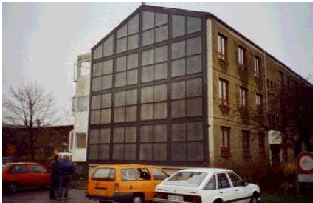
Figur 10: Gavlen efter renovering med integrerede solfangerelementer.
