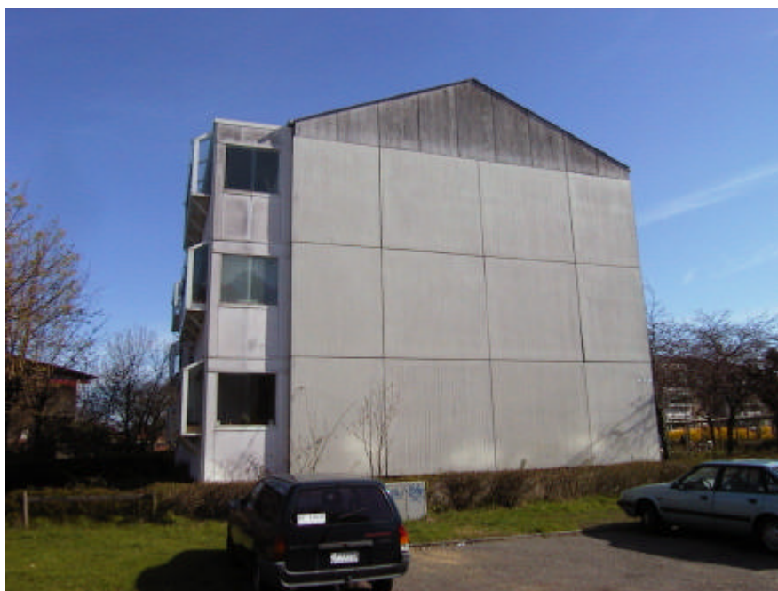
Figur 2: Gavlen på Lønstrupgård før renovering med gavlsolfanger.
