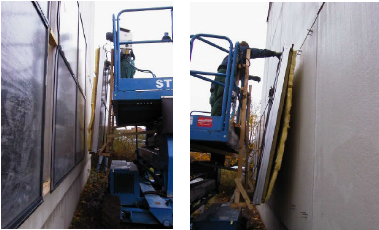
Figur 11: Billeder fra montagesituationen. Elementerne fastgøres til formonterede forankringsbolte.
