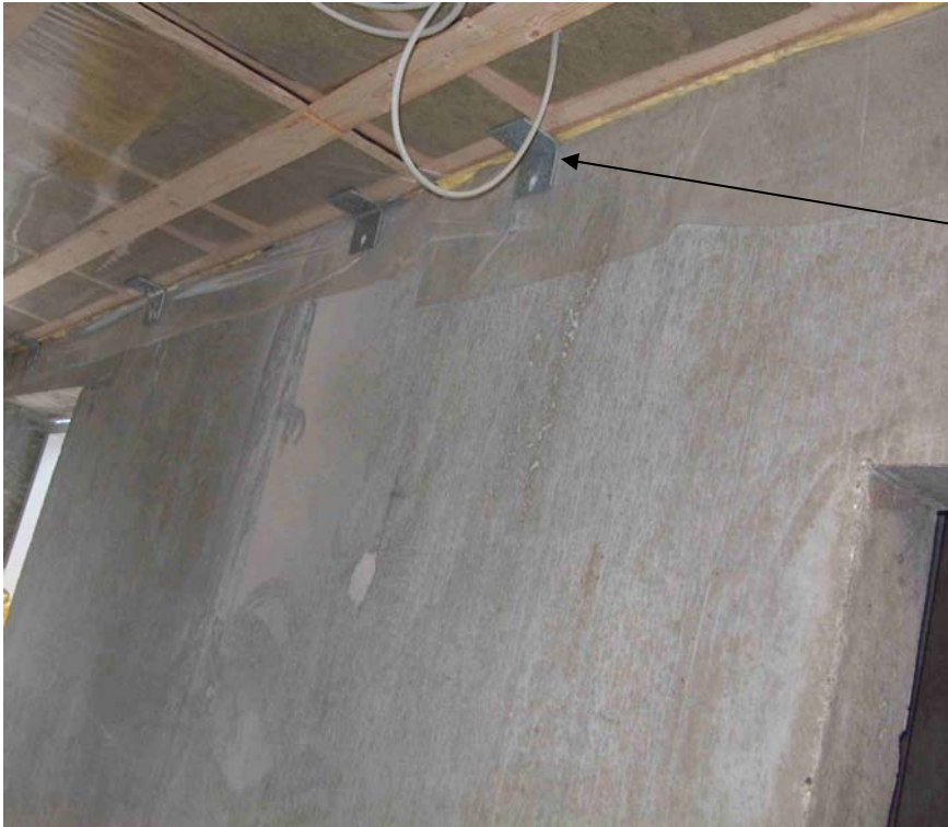
Billede 2 – Beslaget er placeret forkert på tagekassetten.
