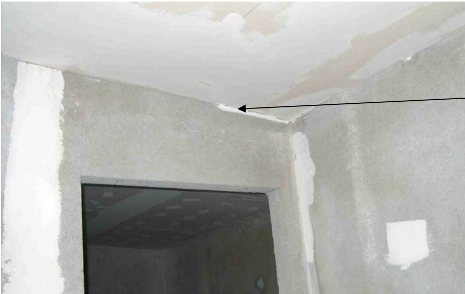
Billede 1 – Samling mellem gipsloft og betonvæg.
