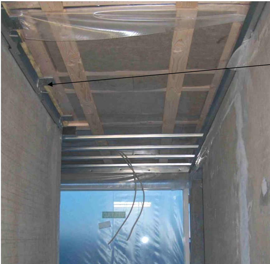
Billede 3 - Beslaget er placeret rigtigt på tagekassetten.
