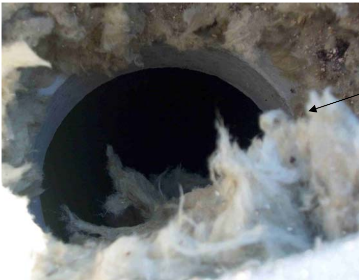
Billede 2 – Nærbillede af Ø200 mm betonhul til ventilationsgennemføring.
