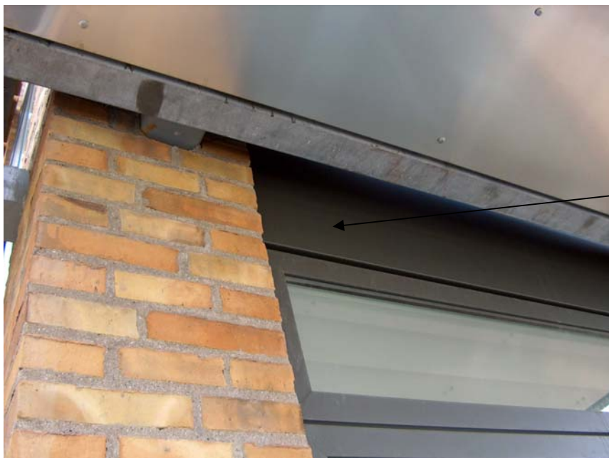
Billede 2 – Aluminiumkassetten er monteret.
