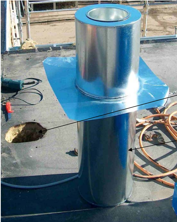
Billede 1 – Ventilationsgennemføring.
