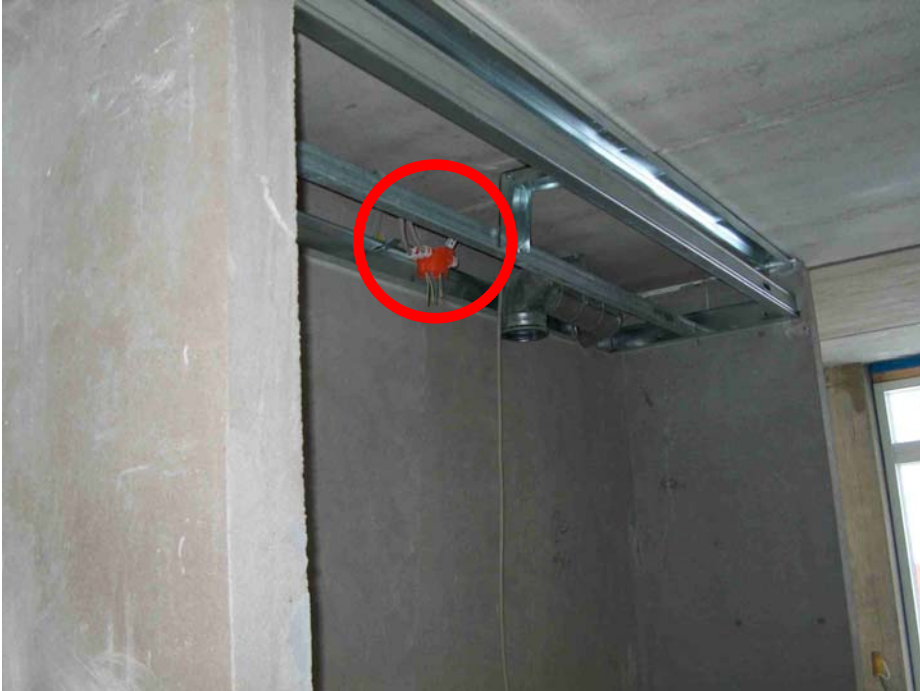
Billede 1 – Anvendte løsning med PL-dåse og bærejern.
