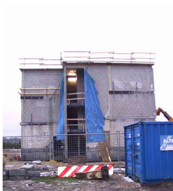
Billede 2 – Manglende overdækning, hvilket skyldes at man har valgt en billig presenning.
