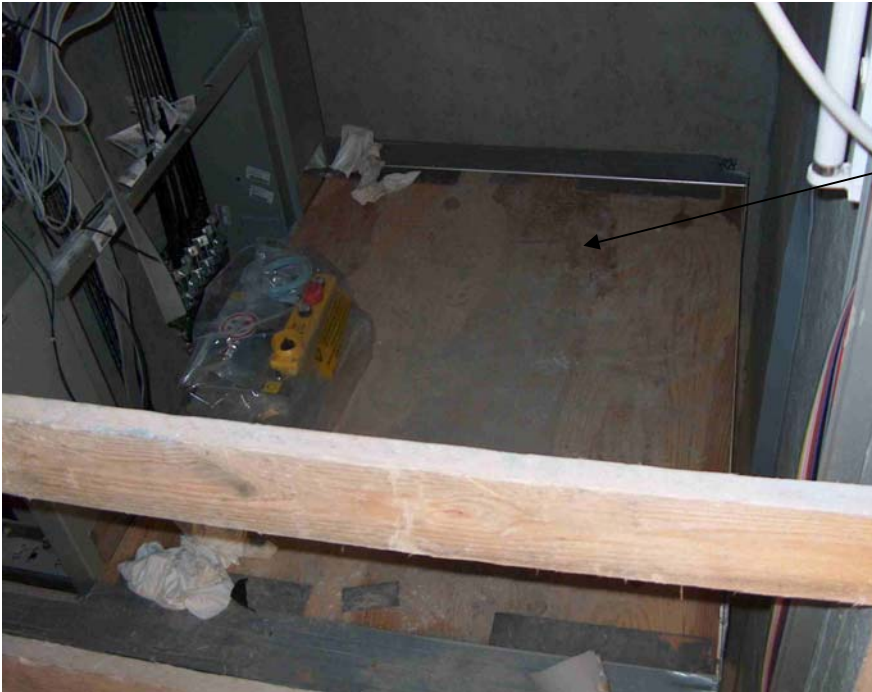
Billede 3 - Viser bunden af elevatorstol med krydsfinersplade.
