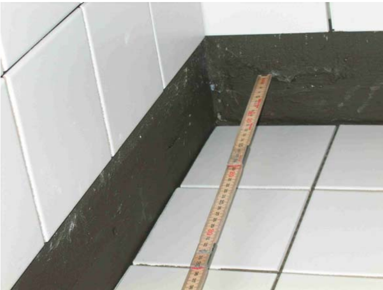
Billede 1 – Ujævn gummimembran.
