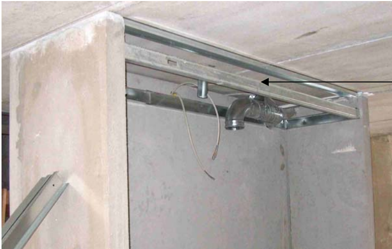
Billede 1 – Anvendt stål til gipsloft i køkkenniche er 45 mm.
