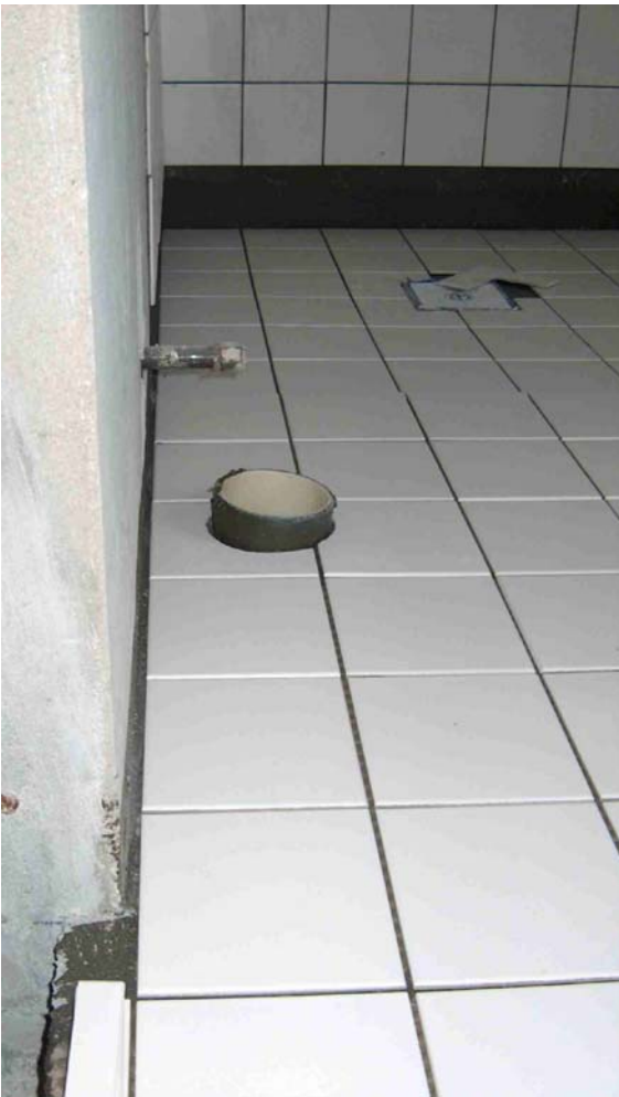
Billede 1 – Skæv vægs indflydelse på fuger.
