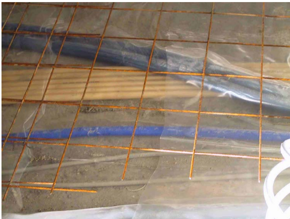
Billede 2 – Den unødvendige højde er der stadig, og kablerne er nu dækket og gulvet er klar til at blive støbt.
