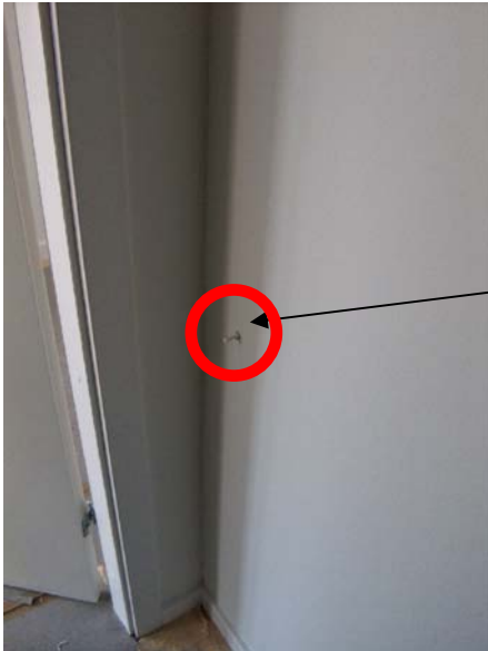
Billede 2 - Søm i betonvæg, den pågældende væg er nu med filt og malet.
