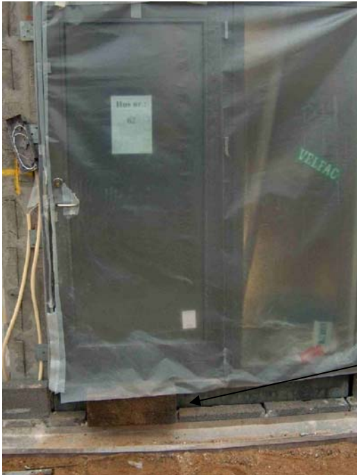
Billede 1 – Sokkelsten ses under dør.
