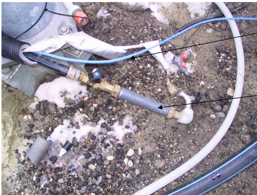
Billede 1 – Ulovlig installation, ingen vandmåler. Derudover er der ingen vinterforanstaltning, da el-tracing ikke er viklet omkring vandhanen.
