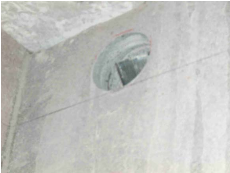
Billede 2 – Streg angiver sænkning af det oprindelige tænkte lofthøjde med 10 mm.
