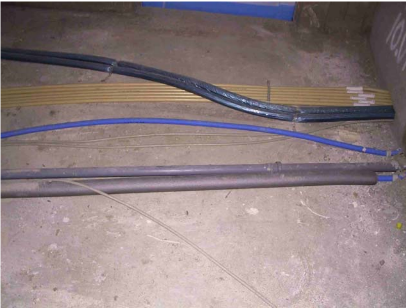
Billede 1 – Der mangler plast og rivnet over rørene.
