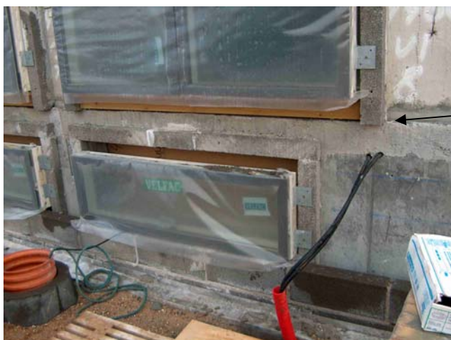
Billede 1 – Fals og bræt i vejen for montering af overlægger ved kældervindue.
