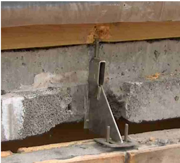
Billede 3 – Nærbillede af afhakket fals og bræt.
