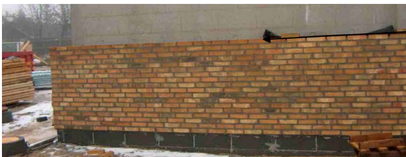
Billede 1 – Overdækningen er kun gjort på halvdelen af muren.
