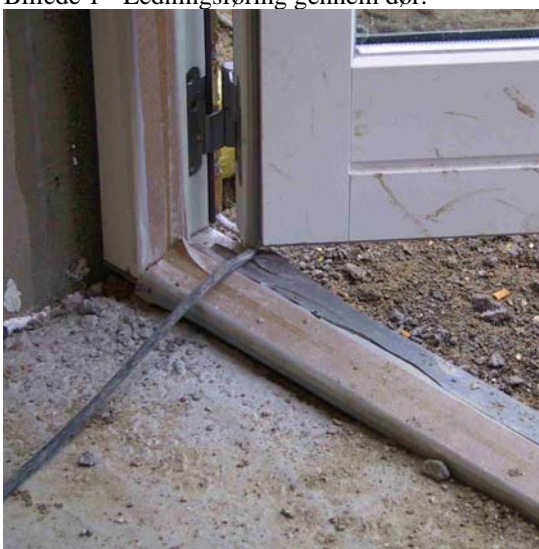
Billede 2 – Ledningsføring gennem dør (zoom)
