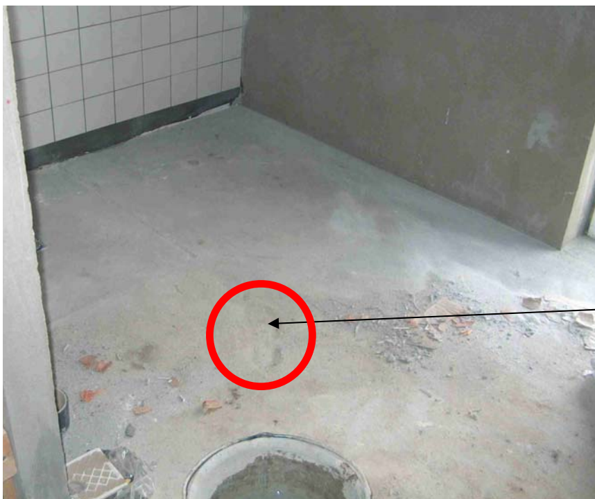
Billede 1 – Fodaftryk i støbt betongulv.
