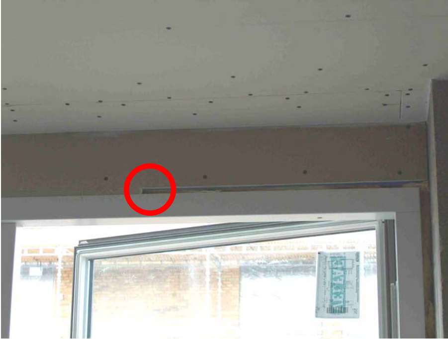
Billede 1 – Viser overkant af vindue, hvor fjernelse af den tilstødende gips er begyndt.
