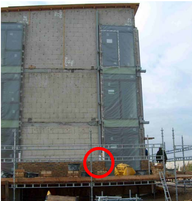
Billede 2 – Monteret altansøjle bag nyopført murværk.
