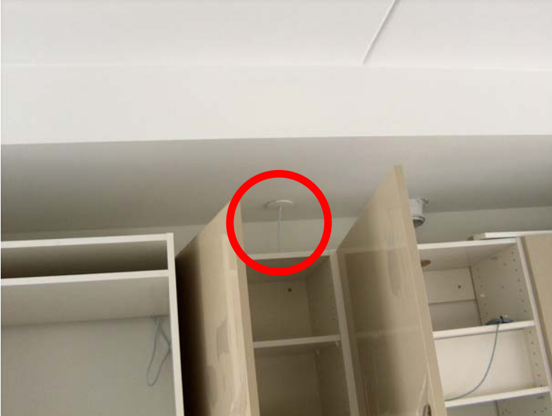
Billede 3 – Køkken er nu monteret og ledning til spots ses.
