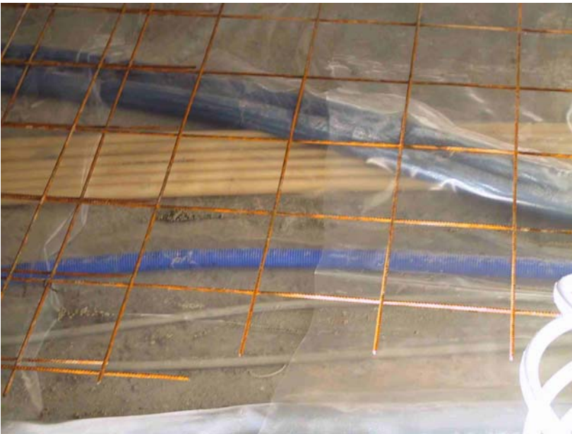
Billede 2 – Der er nu lagt plast og rivnet over rørene.
