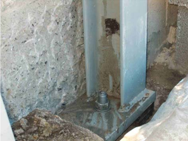
Billede 2 – Nærbillede af monteret altankonsol.
