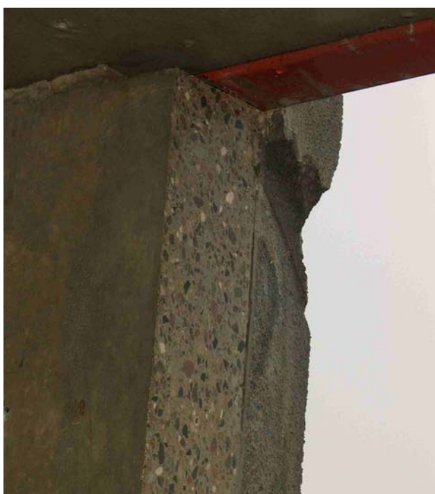
Billede 2 - Tilskæring af vindueshul - zoom.
