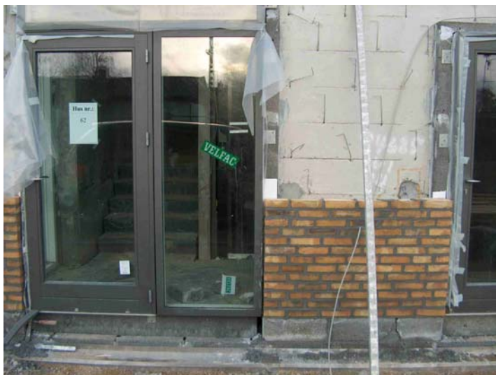
Billede 1 – Opmuring ved indgangsdøre til punkthus.
