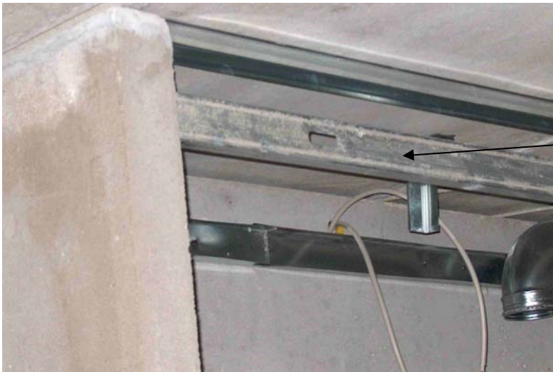
Billede 2 - Anvendt stål/regler til gipsloft i køkkenniche er 70 mm.
