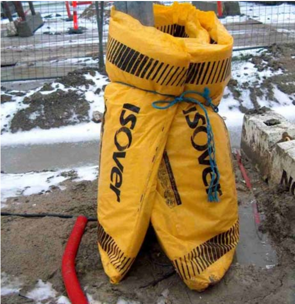
Billede 1 – Foranstaltning – vandhanerne er pakket ind i isoleringsmætter.
