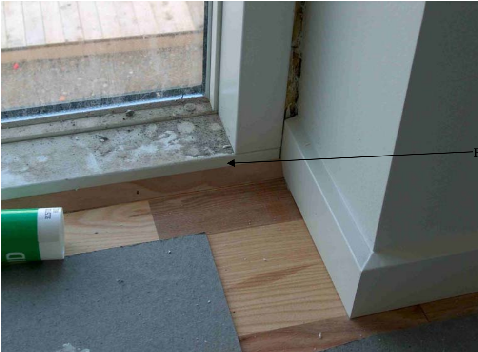
Billede 1 – Bøge-fejelite på askegulv.
