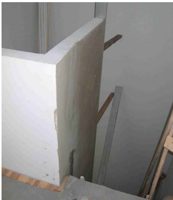
Billede 3 – Opretning af trappeskakt.
