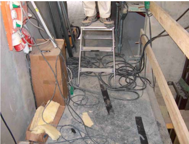
Billede 1 – Ledninger flyder på reposen.
