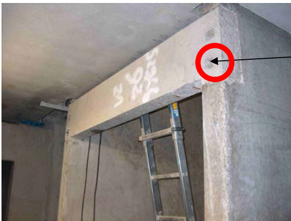
Billede 2 – Overlægger ved elevatorskakt.
