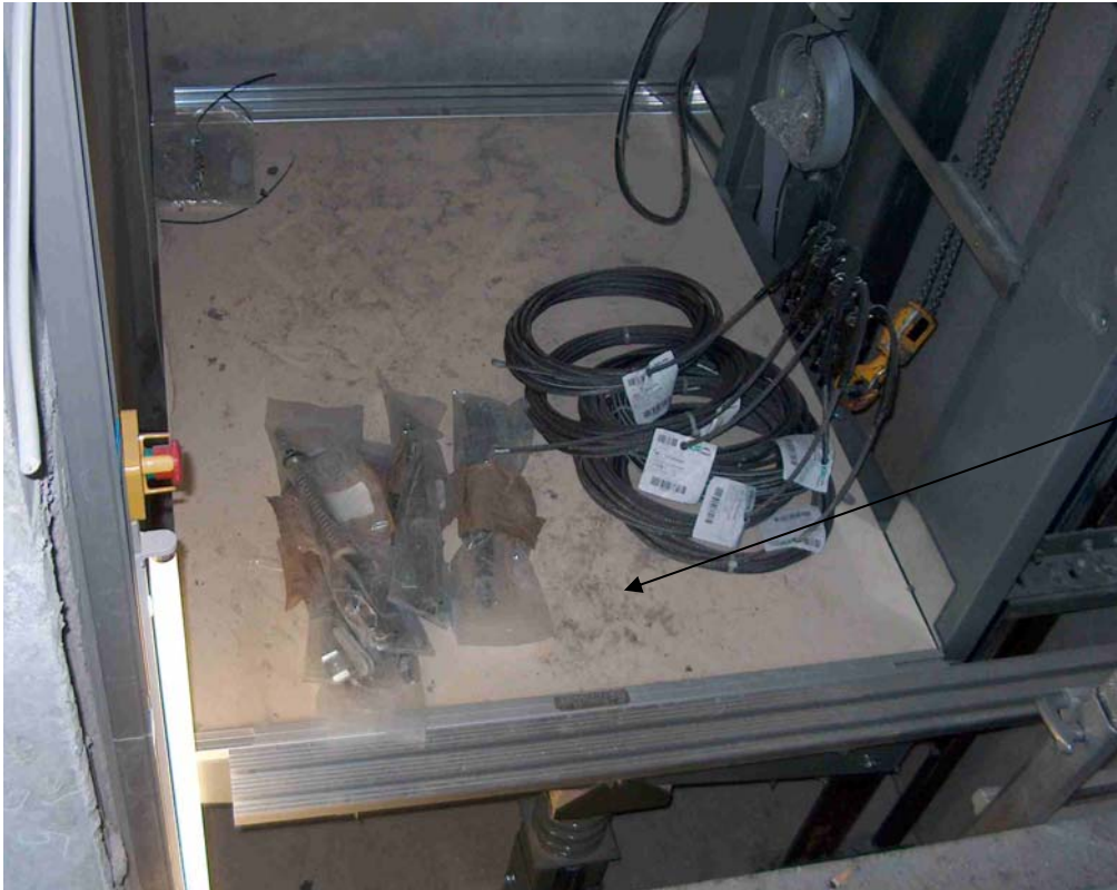
Billede 1 - Viser bunden af elevatorstol uden krydsfinersplade.
