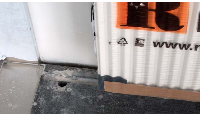
Billede 4 – Hullet fra den tidligere radiator, set i forhold til den nye radiator.
