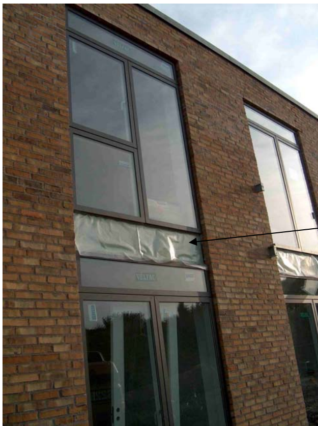
Billede 1 – Udgang til altan – der mangler aluminiumskassetter.
