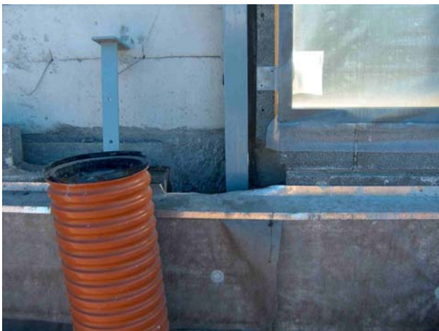
Billede 1 – Altanbeslag monteret på sokkel.
