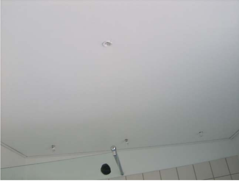
Billede 2 – Udbedret gipsloft.
