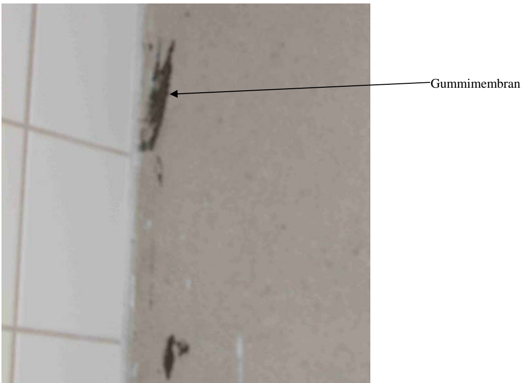
Billede 1 – Rester af gummimembran på badeværelsesvæg.
