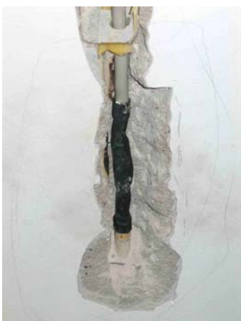
Billede 2 – Reparation af ødelagt ledning udført af elektriker.
