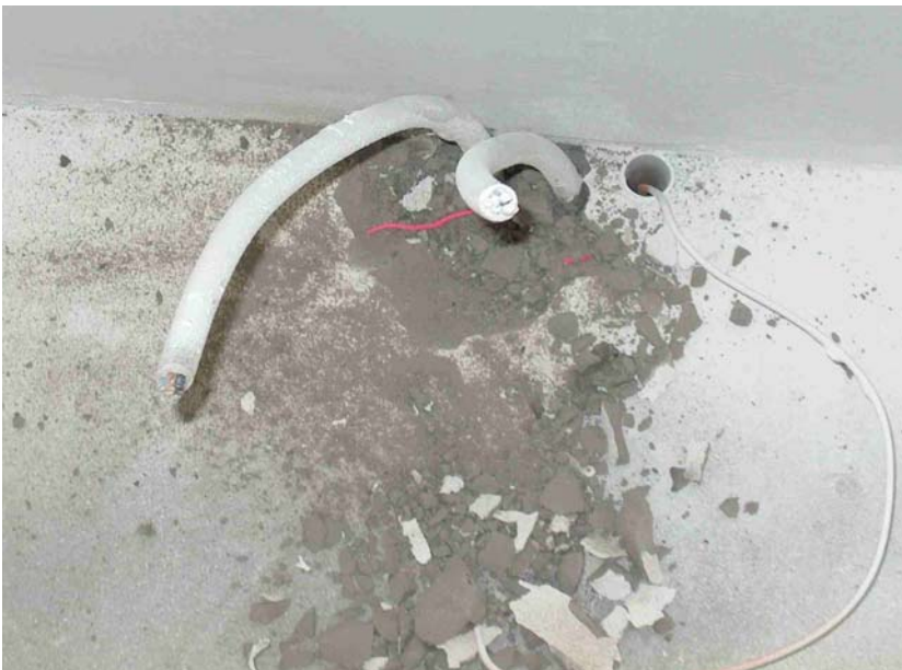
Billede 2 – Der er hakket ud i tyndpuds, så man kan trække ledningen ind til væggen.
