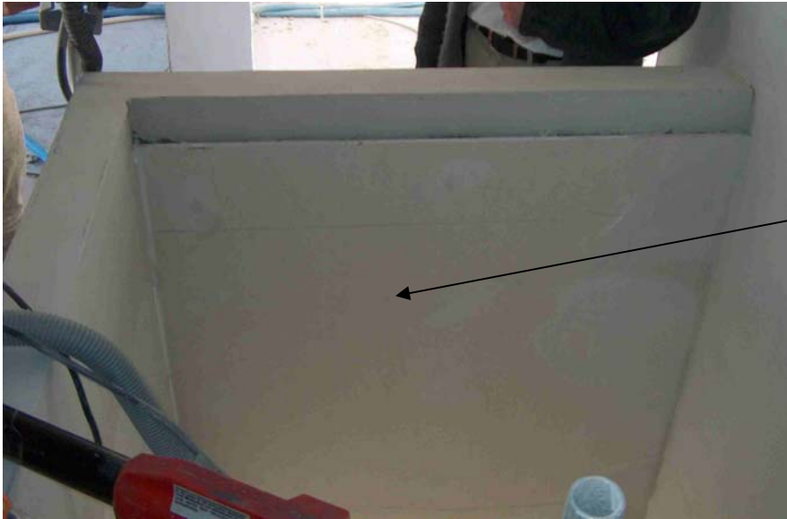
Billede 1 – Gips opad beton ved trappe.
