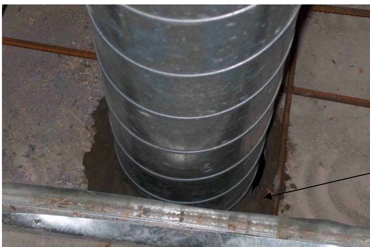
Billede 1 – Beton lagt omkring ikke-fikseret ventilationsrør.
