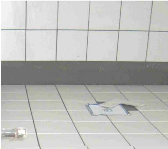
Billede 1 – Afløb i bruseniche.
