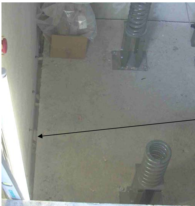
Billede 1 – Der mangler udstøbning af bund i elevatorskakt.
