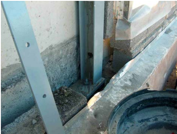
Billede 1 – Monteret altankonsol.
