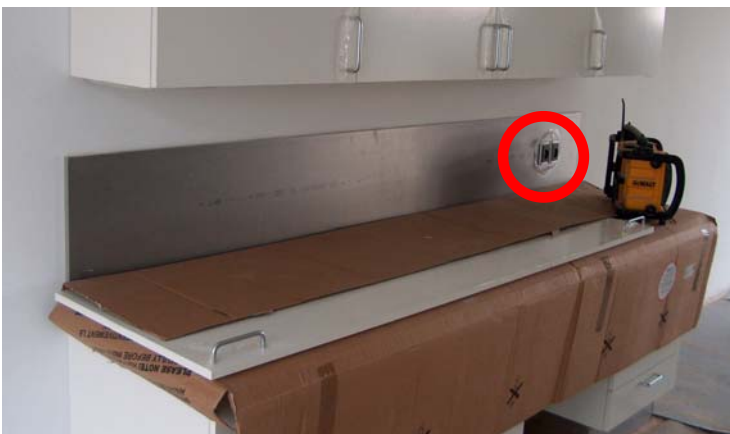
Billede 2 – Der er nu opsat aluplade
