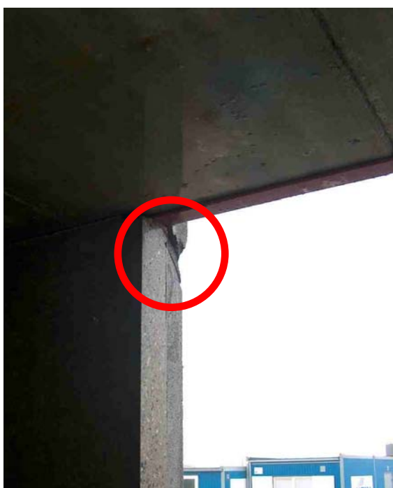
Billede 1 – Tilskæring af vindueshul.
