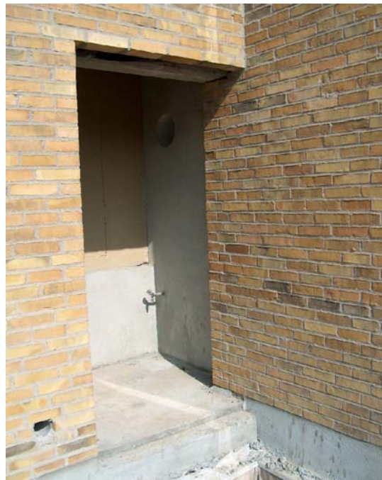
Billede 4 – Affaldsrum i Punkthus 4 og 5
