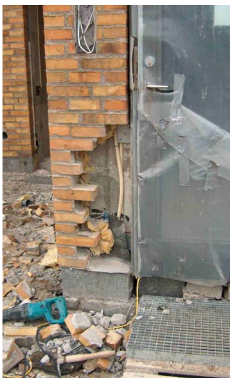
Billede 1 – Murer har fjernet murværk omkring hjørnesøjle (den 10/03-03).
