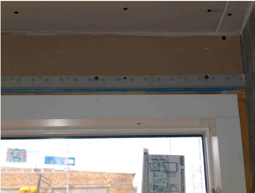
Billede 2 – Løsning ved overkant vindue. Der er endnu ikke lagt fuge, men gipsen er stoppet 1 cm over vinduet.
