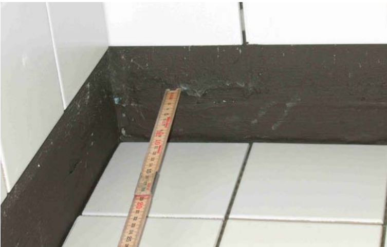
Billede 2 – Ujævn gummimembran.
