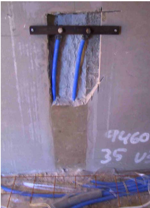
Billede 2 – Viser udhakning af elementet i badeværelset.
