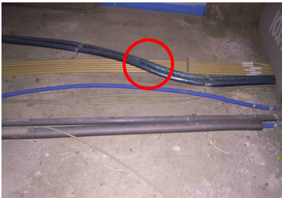
Billede 1 - Man har endnu ikke lagt rivnet, (den unødige højde ses til højre lidt over midten).
