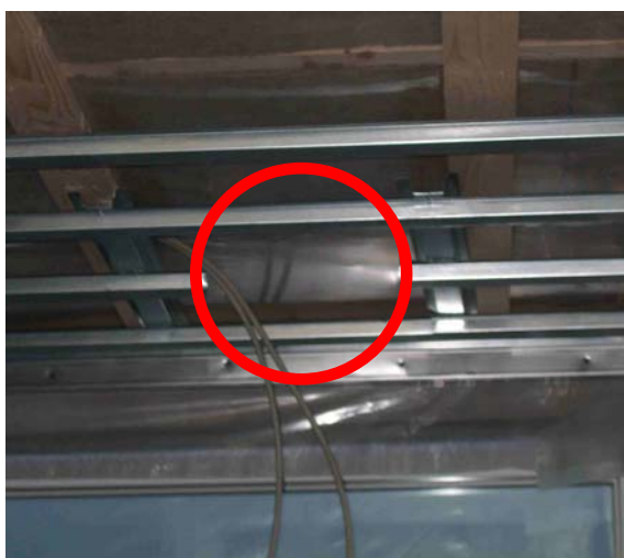
Billede 2 – Der er nu taget højde for lampeudtaget i gipsloftet. Hattestålet er skåret til, så det passer med lampeudtag.
