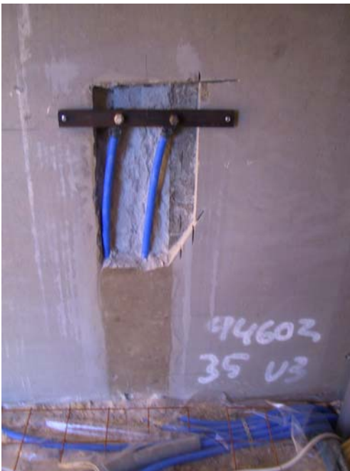
Billede 1 – Udfræsning til armatur.
