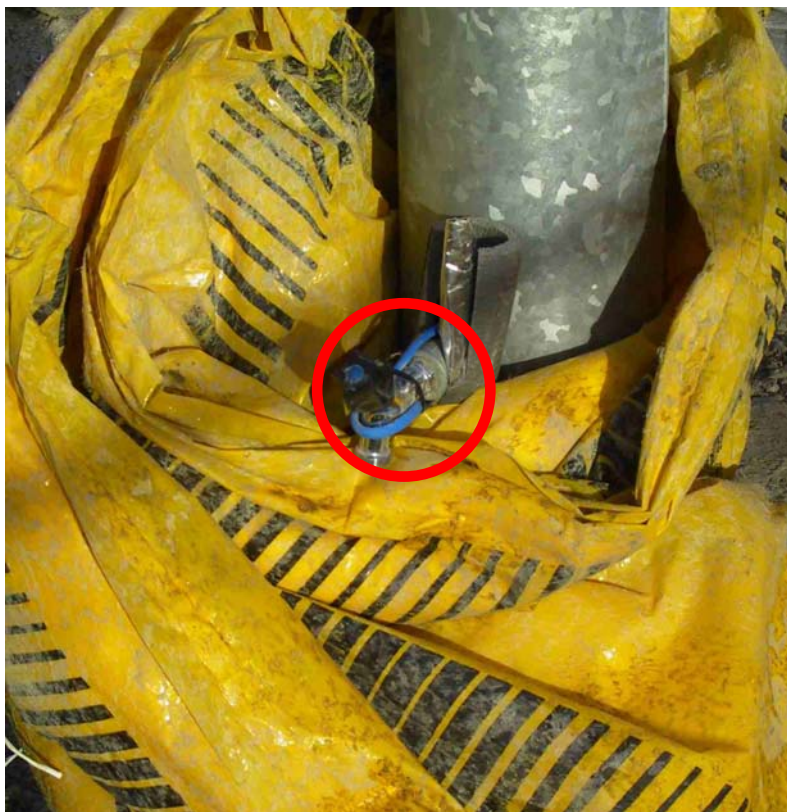
Billede 2 – Byggepladsvandet er nu el-traced, men der er stadig ingen vandmåler på.
