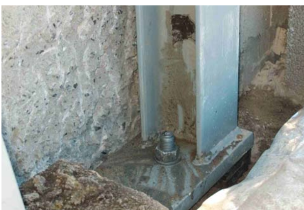
Billede 2 – Altanbeslag monteret på sokkel.
