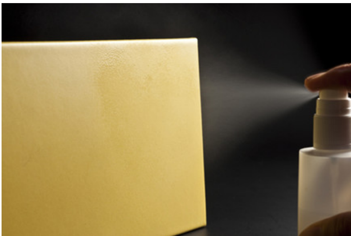
Fig. 10. Aplicación de la composición hidrofobizante Tecnadis PRS® sobre una superficie cerámica. Foto por Pablo Axpe.
