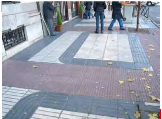
Fig. 14: La profusión de colores y formas en los pavimentos dificultan la utilización del contraste como código de orientación.
