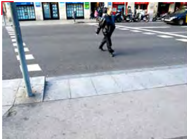
Fig.5a y 5b: los pasos peatonales con escasa pendiente y sin señalización táctil pueden ser peligrosos para personas con discapacidad visual por su incapacidad para detectar el comienzo de la calzada.
