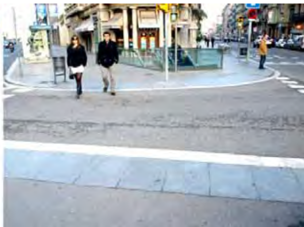
Fig.5a y 5b: los pasos peatonales con escasa pendiente y sin señalización táctil pueden ser peligrosos para personas con discapacidad visual por su incapacidad para detectar el comienzo de la calzada.
