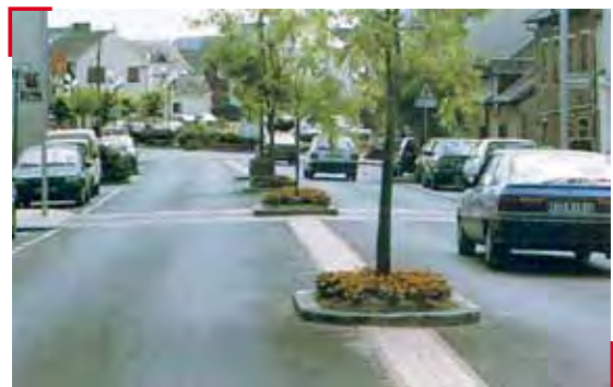
Fig. 13: Ejemplo de vía acondicionada para el cruce transversal peatonal sin prioridad. Rue Nationale, Chante-Pic (Francia).
