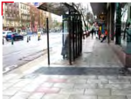
Fig.9: Pavimento señalizador marquesina.
