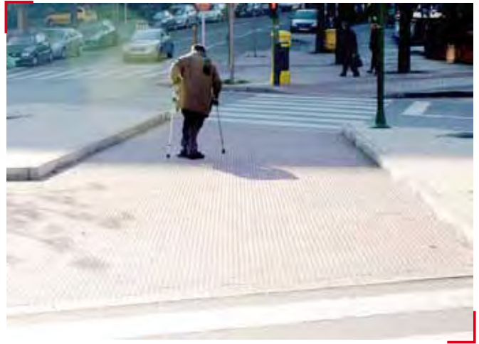
Fig. 12: Una pavimentación completa de la isleta con baldosa de botones puede limitar los beneficios de guía y advertencia de la señalización táctil.
