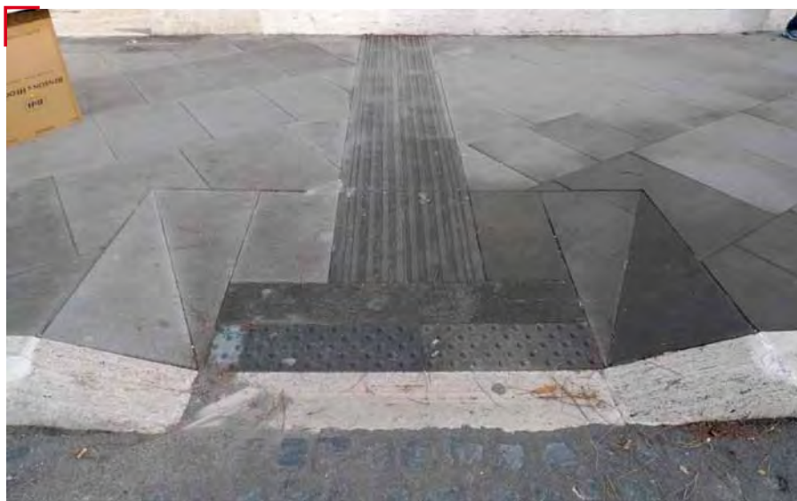
Fig.7: Investigaciones recientes señalan la importancia de separar la señalización de guía y la de advertencia para facilitar la detección de ésta última, como en este vado en Roma.
