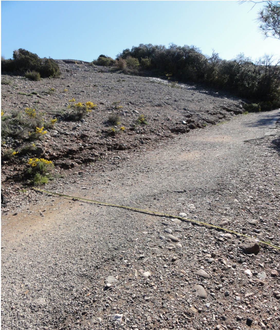
Figura 6. Exemple de mesura amb cinta mètrica de l'amplada del camí.
