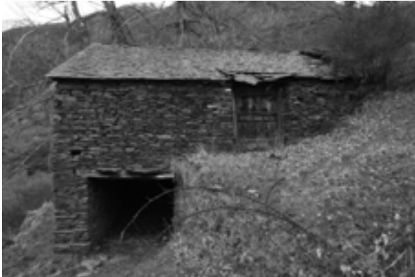
Imatge 1. Vista general d'una borda i detall dels accessos al paller i a l'estable
