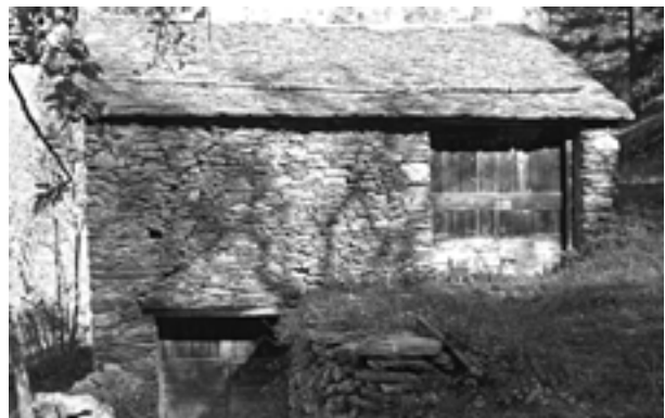
Imatge 2. Detall dels accessos diferenciats al paller i a l'estable de la borda
