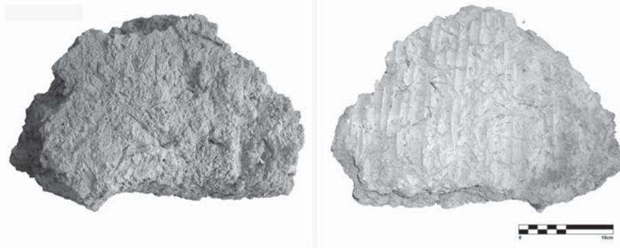
Figura 3.- Sostre/paviment. Peça de procedència de LAM00007.
