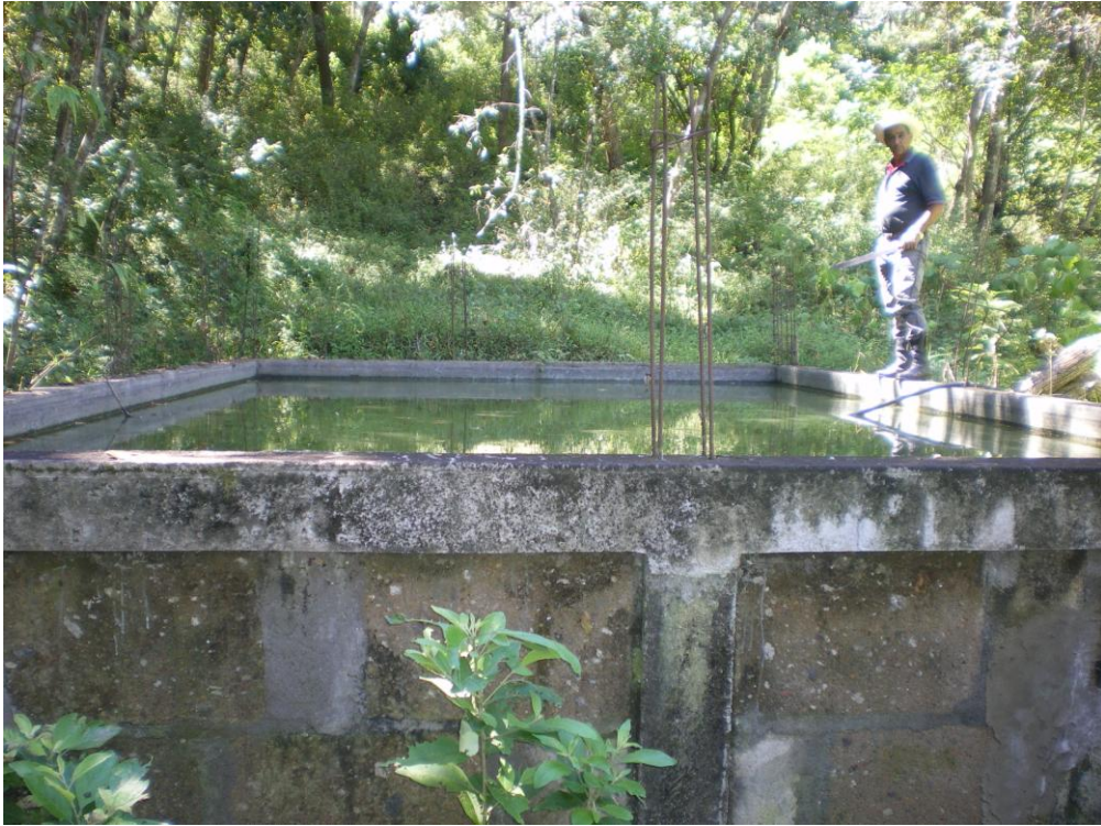
Figura 37: Pila de abastecimiento
