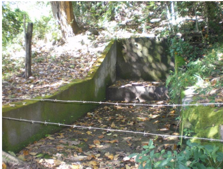
Figura 38: Pila de captación
