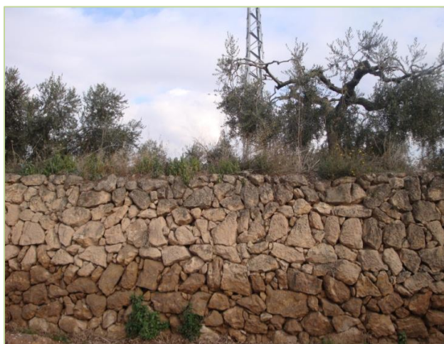
Imatge 4.13. Marge de pedra seca al camí del Mas de la Cuca. Fotografia: Sandra Palacios.
