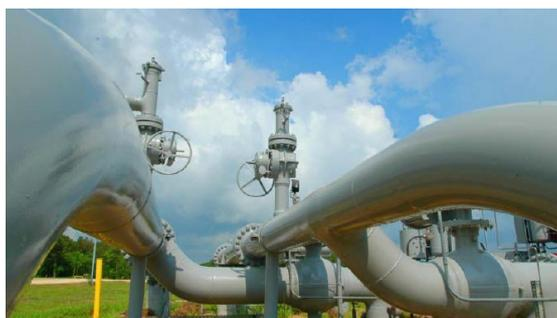
**Figura 5.3** Gaseoductos destinados al transporte de CO<sub>2</sub>. (Johnson, 2008)
