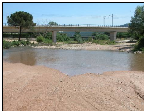
Foto 6: Fi del transecte R9, a l'alçada del pont de la via del tren BCN-Girona.
