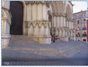
1. Escalera de acceso tramo 1 de 60cm de desnivel en su parte central
