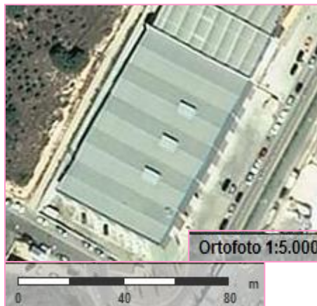
Figura 12.3: Detall de la coberta de l'edifici. Font: ICC
