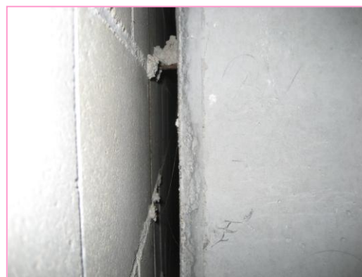
Figura.12.5: Obertura entre la paret de la sala d'oficines i el passadís. Font: elaboració pròpia.
