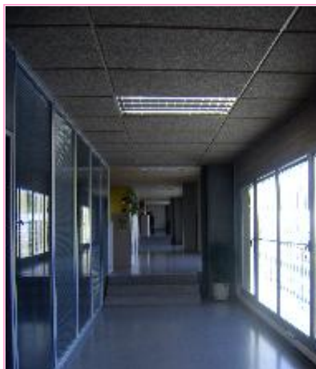
Figura.12.1: Passadís oest de la sala general d'oficines. Font: elaboració pròpia.
