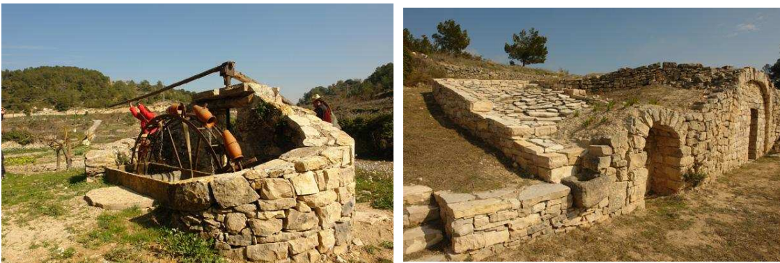
Figura 4.1. Patrimoni de pedra seca a La Fatarella; respectivament, veiem una sènia i, a l'altra fotografia, una cisterna tocant a una cabana. Font: imatges cedides per la Fundació el Solà.
