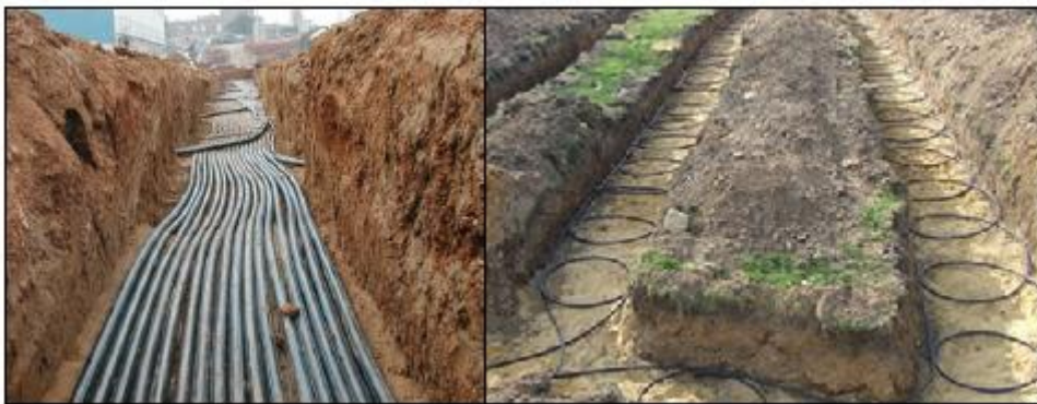
Figura 2.11: Col·lector horitzontal en paral·lel (esquerra) i col·lector horitzontal en espiral (dreta). Adaptat de Aranzazu, M. & Mayoral, G.R. 2009.
