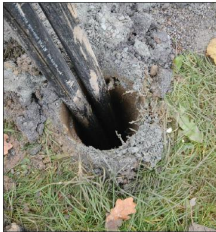
Figura 2.9: Col·lector vertical instal·lat en un pou de perforació. Adaptat de PÉREZ, M. & ZUBIRIA, D., 2009
