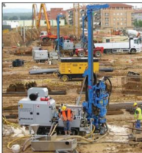
Figura 2.16: Vista de 3 equips de perforació treballant simultàniament en la construcció de l'hospital de Mollet del Vallès. Adaptat de Aranzazu, & M., Mayoral, G.R. 2009.
