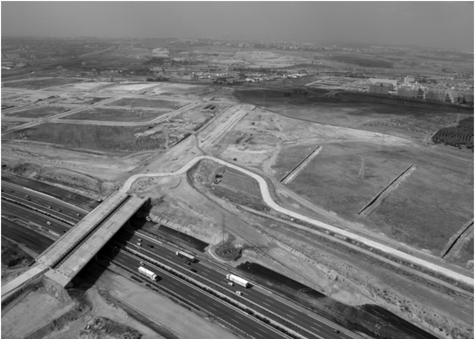
Figura 5. Panorámica de la fase de sondeos en la Zona de Exclusión Arqueológica, junto a la zona de Vías Colectoras (Cortesía de la Junta de Compensación de la UZP2.01 El Cañaveral).
