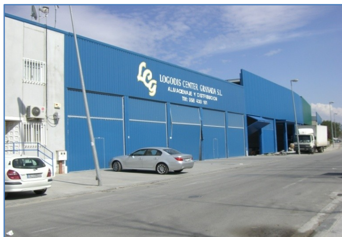
Figura 10. Foto de las instalaciones de Logodis.
