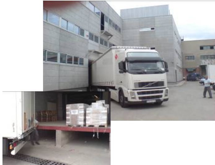
Figura 4.2.3 Detalle del muelle de carga
