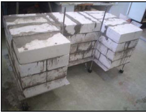
Figura 27. Construcción del refractario
