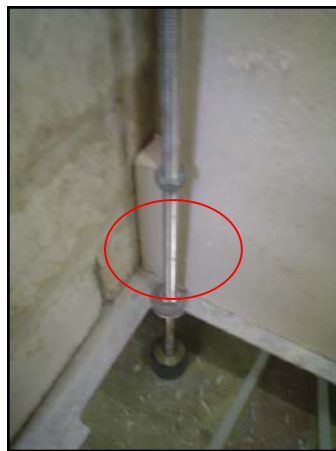
Figura 23. Topes para regular la altura
