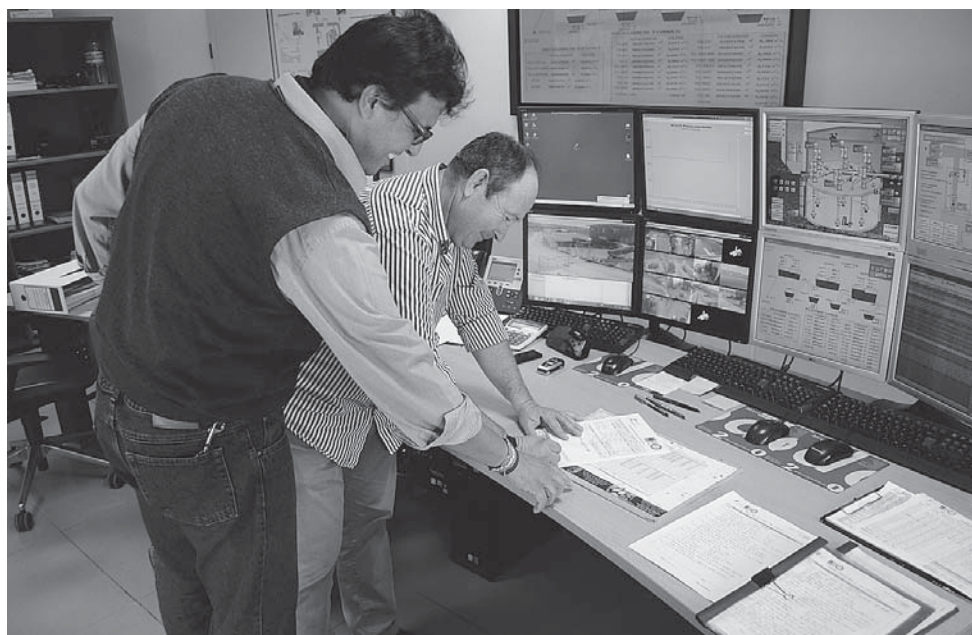
FIGURA 14 INTERIOR DEL CENTRO DE CONTROL DEL TRASVASE NEGRATÍN-ALMANZORA EN EL SALTADOR (ALMERÍA, 07-11-2013)
