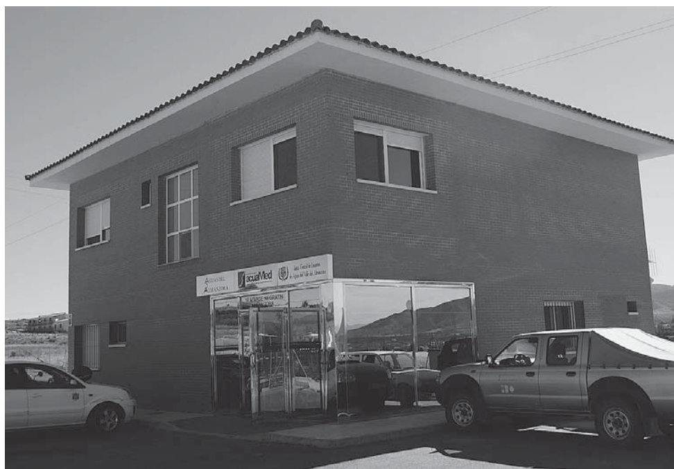
FIGURA 7 CENTRO DE CONTROL DE AGUAS DEL ALMANZORA, S.A. PARA LA GESTIÓN DEL TRASVASE NEGRATÍN-ALMANZORA, EN EL SALTADOR DE HUÉRCAL-OVERA (07-11-2013)
