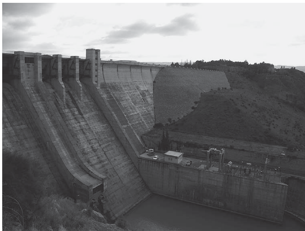
FIGURA 5 PRESA DEL EMBALSE DEL NEGRATÍN. CUENCA DEL GUADALQUIVIR (GRANADA, 21-01-15)
