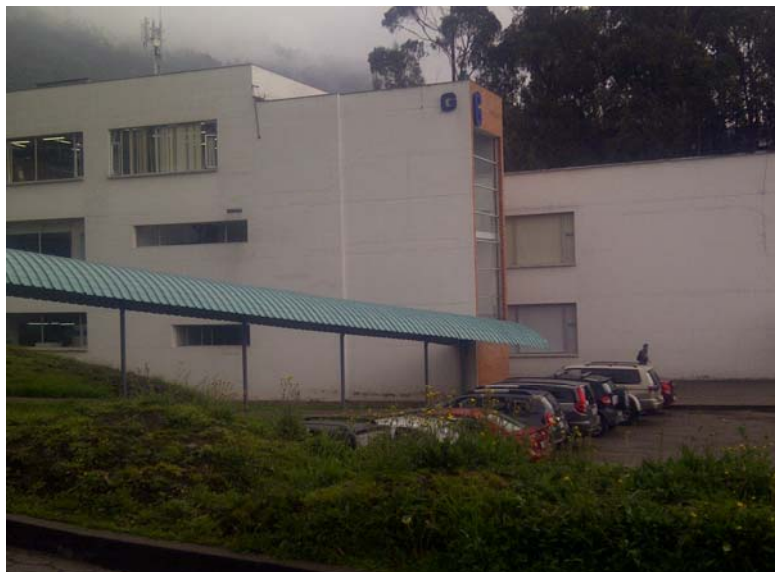
FIGURA 6. 2 2 Bloque G, de la Facultad de Ciencias de la Ingeniería e Industrias, donde se encuentra: Laboratorios (mecatrónica, alimentos, física, química, área administrativa del campus, aulas, petróleos. centros de investigación)
