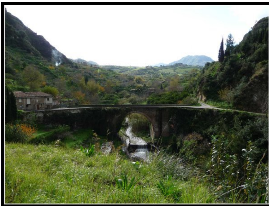
Veduta Ponte Grande Comune di Castoreale (ME)
