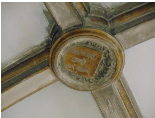
Figura 47 - Chave ornamental na abóbada de cruzaria de uma das capelas laterais
