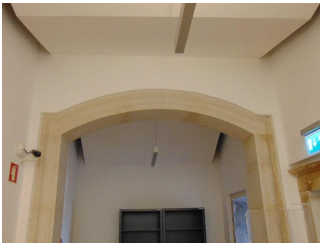
Figura 27 - Pormenor de um arco no 1º piso dos dormitórios
