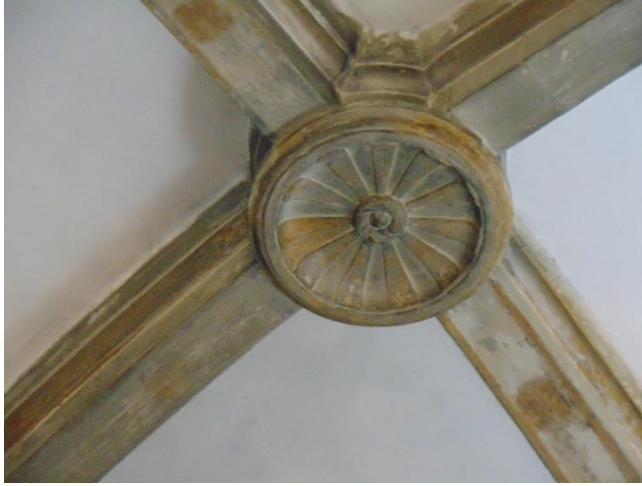
Figura 48 - Chave ornamental na abóbada de cruzaria de uma das capelas laterais
