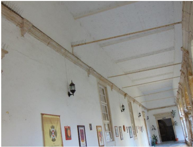
Figura 4 - Pormenor de uma das alas do claustro que não tem abóbada
