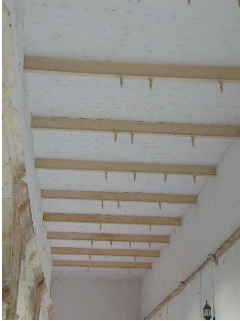
Figura 5 - Pormenor dos ganchos numa das alas do claustro que não tem abóbada
