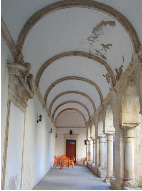
Figura 3 - Pormenor da outra abóbada do claustro
