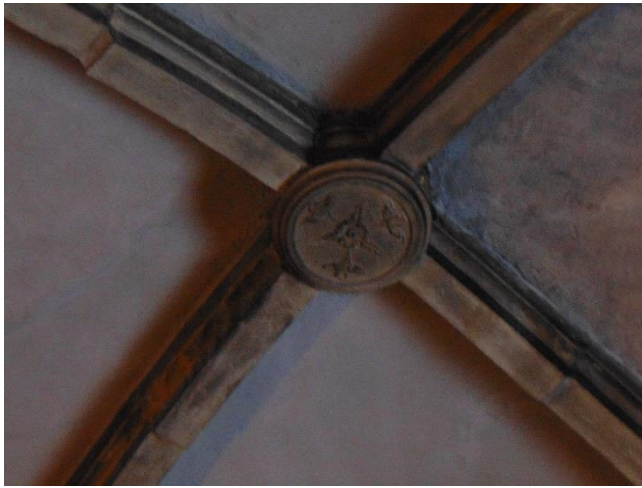
Figura 49 - Chave ornamental na abóbada de cruzaria de uma das capelas laterais
