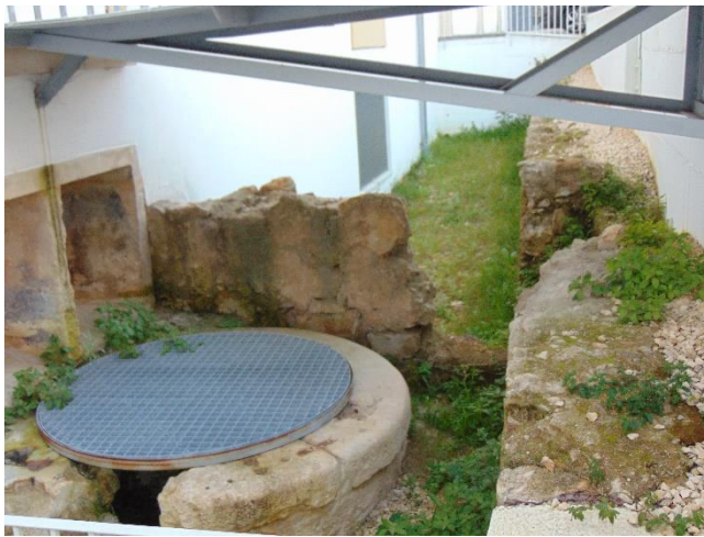
Figura 40 – Pormenor do bocal da cisterna, posta a descoberto após escavações, aquando do restauro dos dormitórios.
