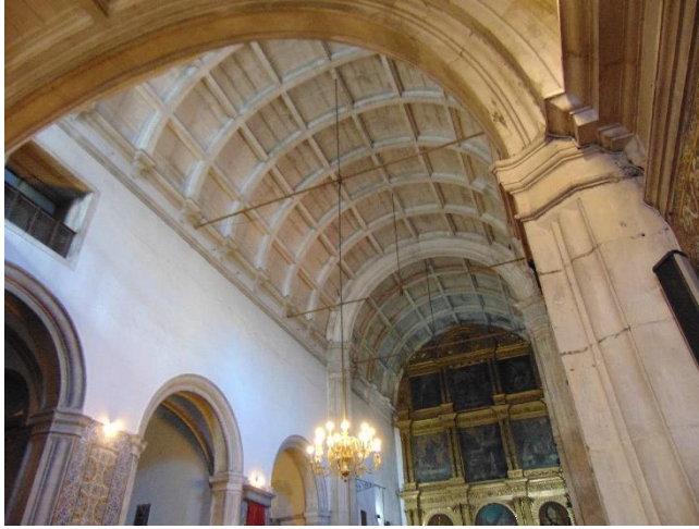
Figura 45 - Abóbada de caixotões na Igreja de Nossa Senhora da Graça
