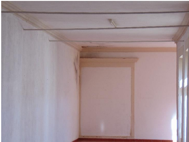
Figura 18 - Pormenor do portal falso presente no 2º piso do claustro
