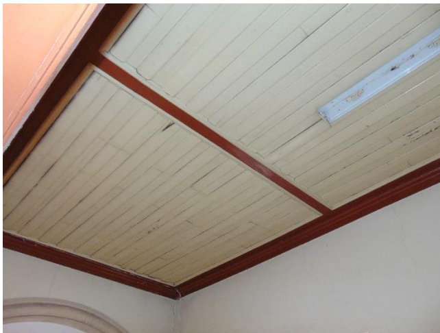
Figura 22 - Tecto em madeira no 3º piso
