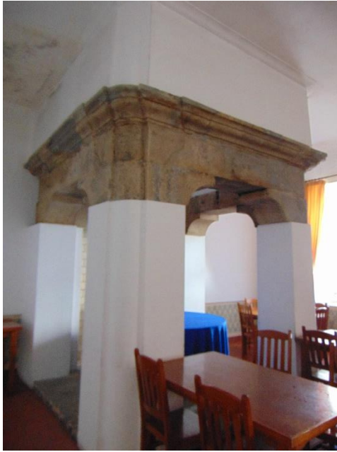
Figura 11 - Pormenor do possível forno da cozinha do Colégio da Graça
