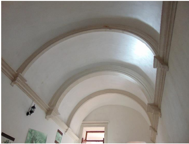
Figura 15 - Abóbada de berço da escada de acesso ao 2º piso do claustro
