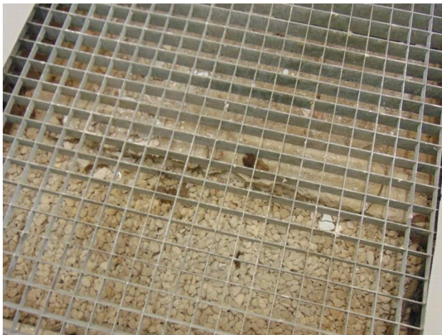
Figura 44 - Sistema de escoamento de águas, junto às fundações
