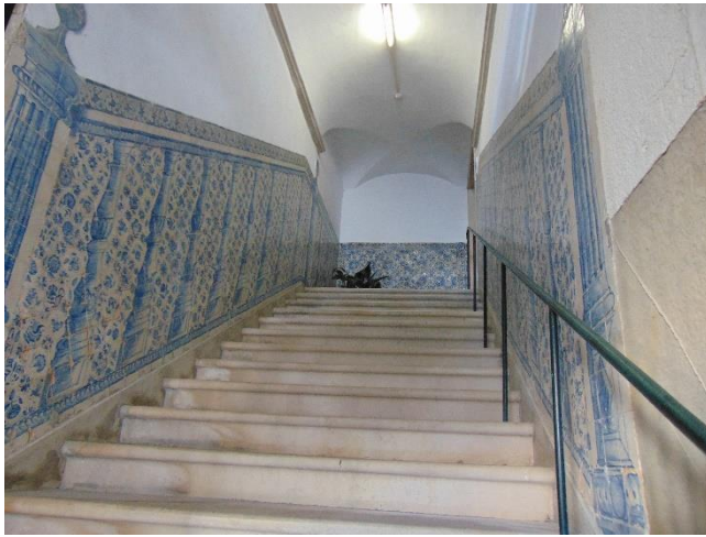
Figura 21 - Pormenor da abóbada de cruzaria numa das escadas de acesso ao 2º piso do Colégio
