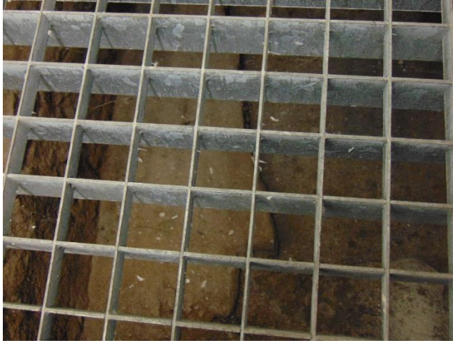
Figura 42 - Fundação presente no piso que estava soterrado, até às escavações que o puderam a descoberto
