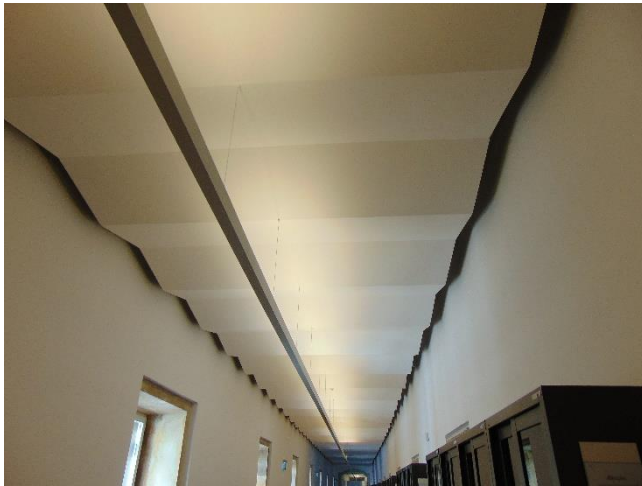
Figura 26 - Corredor dos dormitórios do 3º piso após restauro do CD25A
