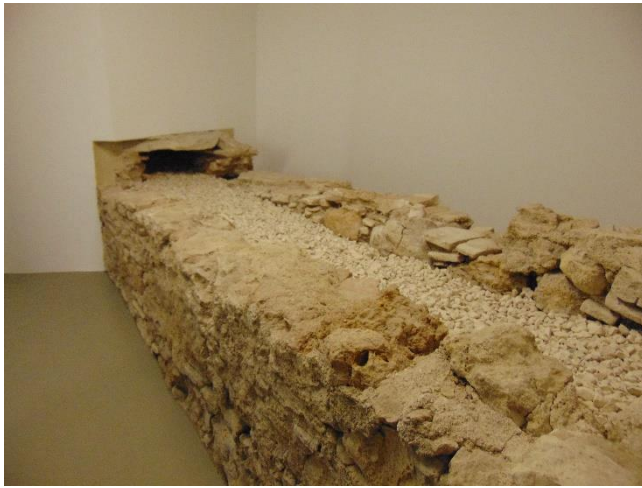
Figura 43 - Sistema de escoamento de águas
