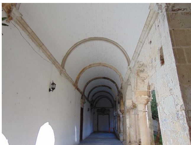
Figura 2 - Pormenor da abóbada de uma das alas do claustro
