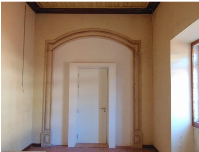
Figura 24 - Pormenor de um arco no 3º piso
