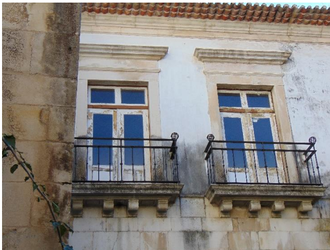
Figura 19 - Pormenor das "varandas" sobre mísulas
