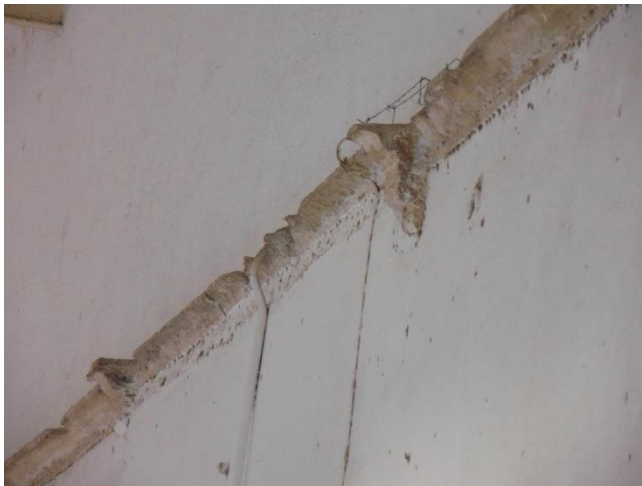
Figura 6 - Cimalha do claustro com vestígios de mísulas
