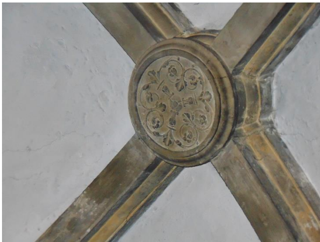
Figura 50 - Chave ornamental na abóbada de cruzaria de uma das capelas laterais
