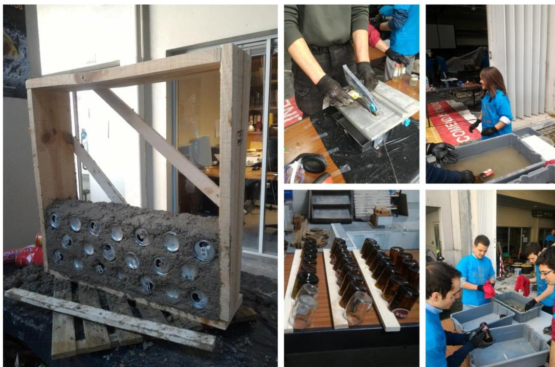
Figura 94 – Ensaio e exemplificação constructiva de uma parede Earthship na FEUP
