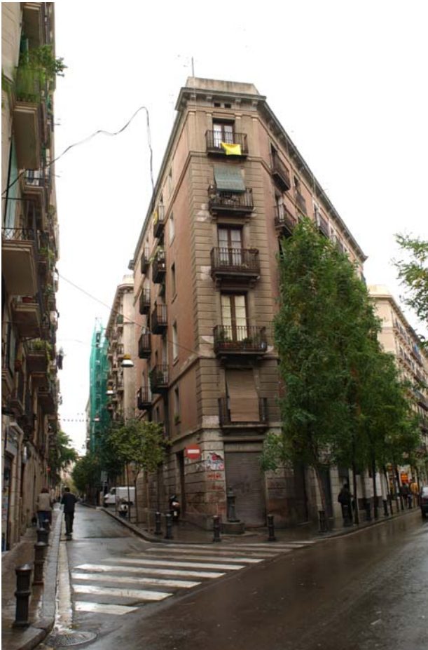
Figura 2. Edifici Miquel Faralt, carrer de la Lluna, 1. Primer habitatge de la família Ramón-Fañanás a Barcelona.
