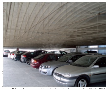
Bóveda arcos atirantados de hormigón, B+1, 2013
