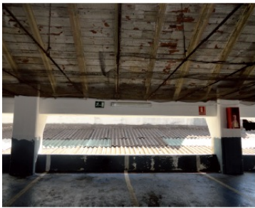
Estructura de cubierta, 2013
