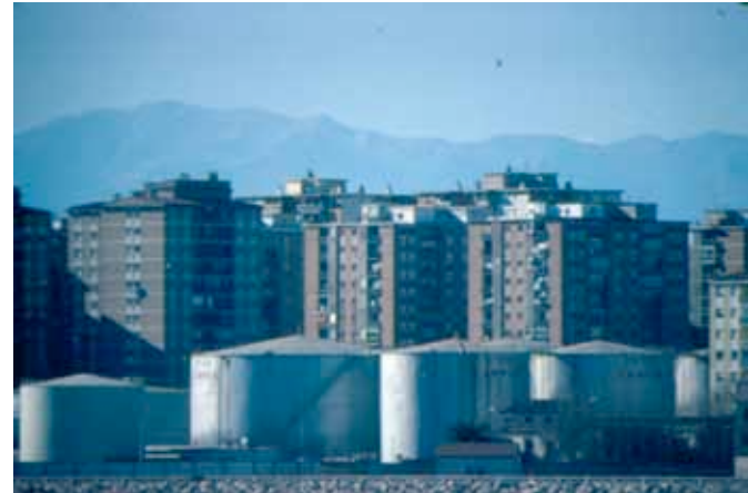
[140] A la periferia se le aplicó la misma mirada que a las áreas centrales, en la búsqueda de una estructura que ordenase los barrios, dotándolos de imagen urbana y nuevas centralidades. En el caso de las áreas industriales incompatibles con el uso residencial, como las áreas de bidones de CAMPSA y ENPETROL, éstas fueron calificadas de espacios libres.
