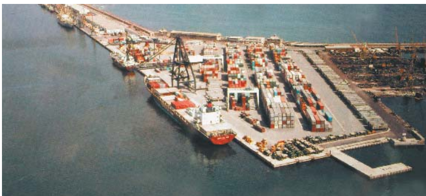
Terminal de Contenedores en la Prolongación del Muelle de Levante en 1974. Autoridad Portuaria de Valencia.
