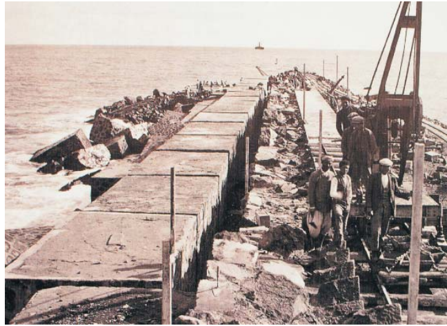
La construcción del Puerto de Melilla mediante el empleo de bloques artificiales es la escena que contempla la foto. Autoridad Portuaria de Melilla.
