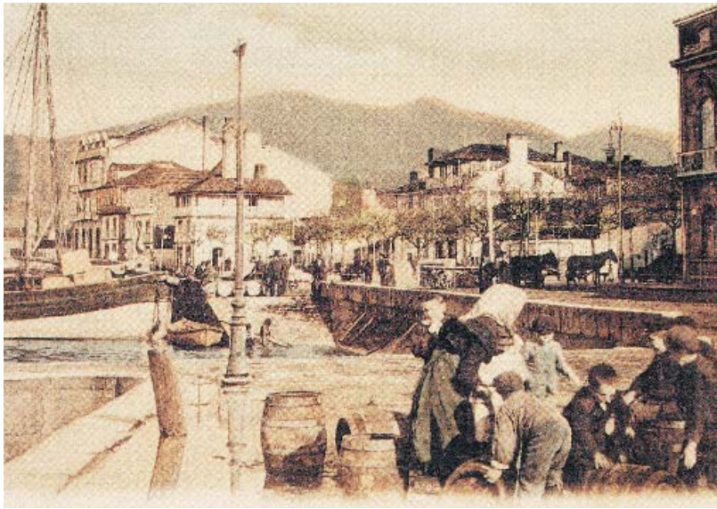
Postal de Vilagarcía en la que se contempla La Alameda desde el muelle de piedra en el Puerto de Vilagarcía.
