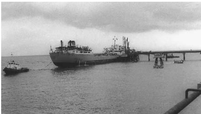
Pantalán de CEPSA y el buque-tanque "Albuera" atracando con la ayuda de un remolcador en 1965. Arxiu Central Port de Tarragona.
