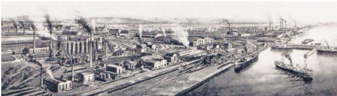
Vista de la Compañía Siderúrgica del Mediterráneo y las instalaciones del Puerto de Sagunto en 1928.
