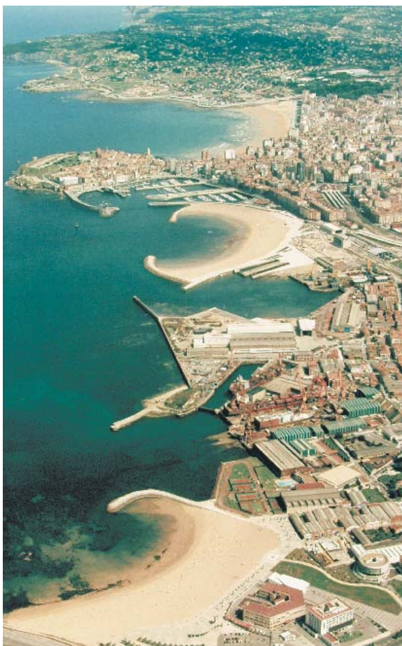
Foto aérea donde se ve la zona industrial y los astilleros del Puerto de Gijón, con las playas de Poniente y Arbeyal a fines del siglo XX. Autoridad Portuaria de Gijón.
