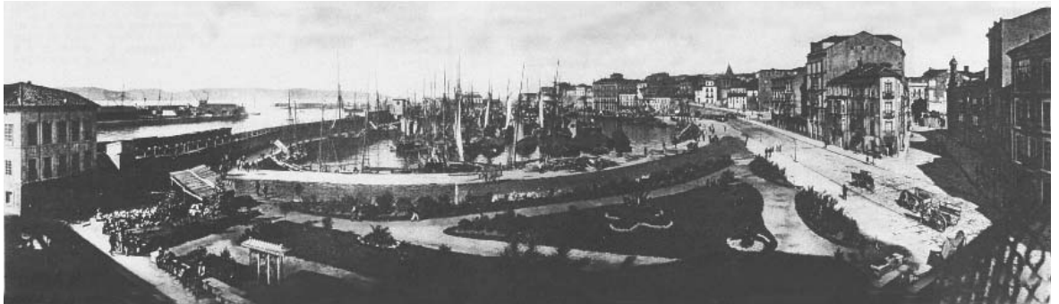
La Dársena local a principios del siglo XX. Se observa a la izquierda el muelle del carbón por el que circula un convoy del tren en dirección a los drops. Autoridad Portuaria de Gijón.
