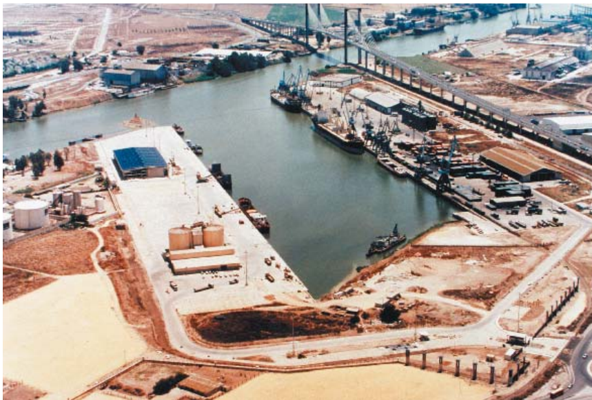
Puente del Centenario, a la izquierda se aprecia la Dársena de Batán en 1992. Autoridad Portuaria de Sevilla.
