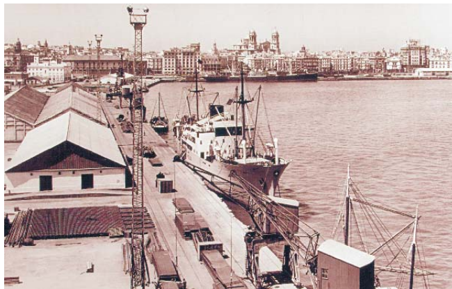
La Dársena comercial del Puerto de Cádiz vista desde el edificio frigorífico en el extremo del muelle Marqués de Comillas. En primer plano las nuevas carretillas eléctricas adquiridas a principios de los años cincuenta. Foto tomada en 1954. Autoridad Portuaria de Bahía de Cádiz.
