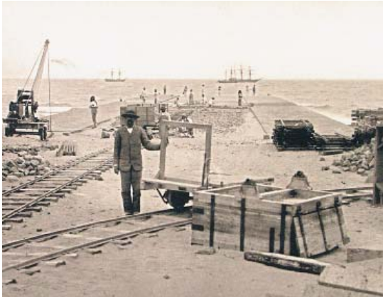
El inicio de las obras del Puerto de La Luz. Cámara Oficial de Comercio, Industria y Navegación de Las Palmas.
