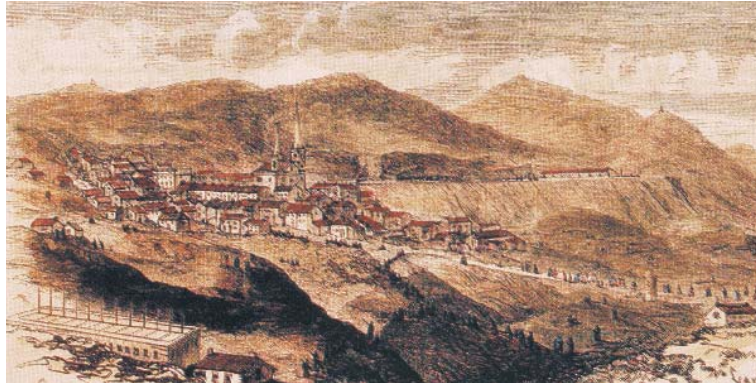
Grabado del pueblo de Minas de Riotinto en el momento de la inauguración del ferrocarril a Huelva. Archivo Diputación Provincial de Huelva.
