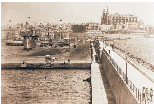
El paseo peatonal del Puerto de Palma de Mallorca, la Riba en 1918, permitía la contemplación de las actividades portuarias sin interferir en las operaciones de manipulación de las mercancías. Autoridad Portuaria de Baleares.
