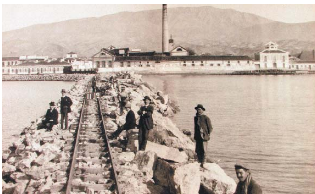
En primer plano el dique de Levante en construcción y al fondo el muelle de Costa del Puerto de Motril a principios del siglo XX. Autoridad Portuaria de Almería-Motril.
