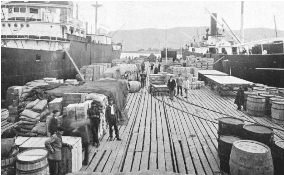
Escena comercial del tráfico llevada a cabo en el muelle de Hierro, reconstruido tras el temporal que asoló el Puerto de Vigo en 1922. Memoria 1926, Autoridad Portuaria de Vigo.
