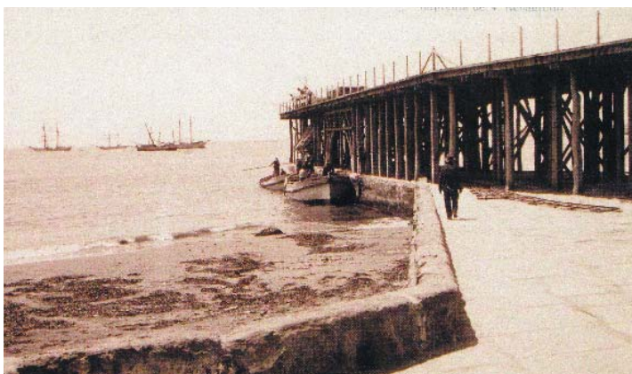
Embarcadero de sal del Puerto de Torrevieja en 1925, construido en 1898 y conservado hasta 1958. Colección Juan Ferrer Marsal.
