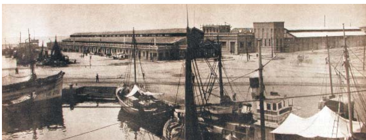
Vista panorámica de la Pescadería con las nuevas ampliaciones en construcción del Puerto de Málaga. Memoria 1940-1944, Autoridad Portuaria de Málaga.
