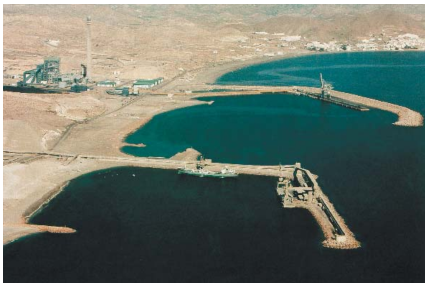
Conjunto Portuario de Carboneras, en primer plano el Puerto de Hornos Ibéricos y al fondo Pucarsa, especializado en el tráfico de carbones. Autoridad Portuaria de Almería y Motril.
