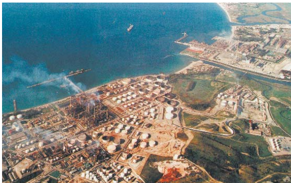
La refinería CEPSA motor de la industrialización en el Campo de Gibraltar. Autoridad Portuaria de Bahía de Algeciras.
