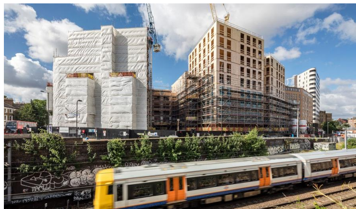
Figur 2: Dalston Lane under opførelse.
