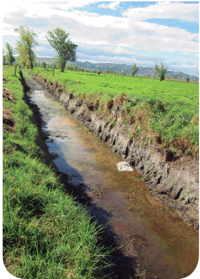
Figura 20. Drenajes para recolección de exceso de humedad en los lotes.
