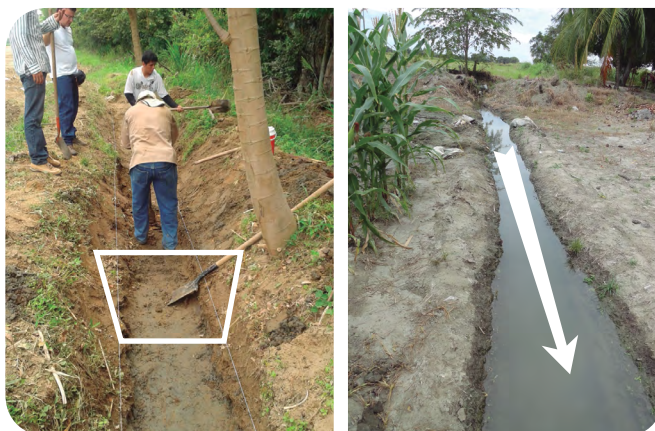
Figura 34. Adecuación de entradas y salidas de agua para instalación de un aforo.
