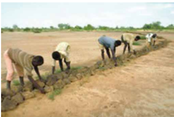
Photo 4.15 Diguettes construites par des agriculteurs pour gérer les sols sur des terrains en pente au Burundi.
