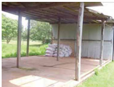
Photo 5.4 Un magasin d'engrais doit avoir un toit étanche et un plancher dur. Les engrais doivent être stockés sur des palettes en bois pour empêcher la formation de croûtes.
