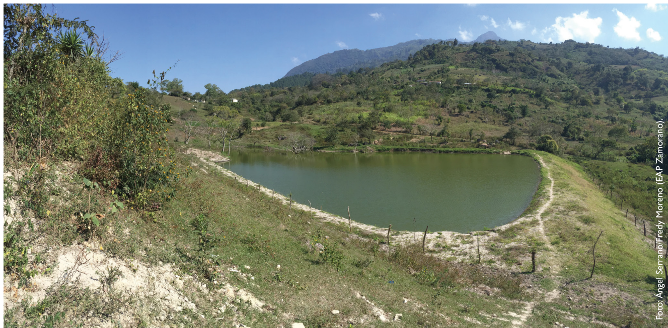
Reservorio de cosecha de agua lluvia para uso agrícola, Lempira, Honduras.
