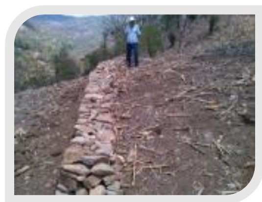
Fotografía 12. Muro de piedra/ Barrera muerta
