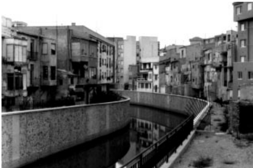
Foto 5. Orihuela. Degradación del caserío en la fachada fluvial. Imposibilidad de circulación paralela al cauce. 1996.
