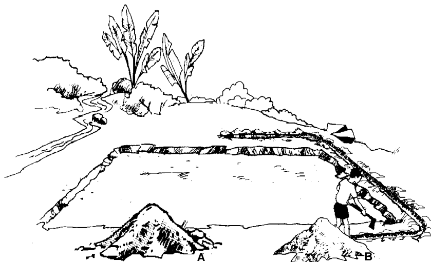
Figura 11: Escavando uma “vala central” (A) (Murnyak, 1990)
