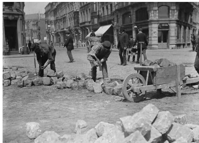
Foto 33. Kasseileggers op het einde van de negentiende eeuw aan het werk op het kruispunt van de Vlaanderenstraat en de Brabantdam in Gent. Tijdens de oorlog werden er verschillende openbare werken uitgevoerd om werklozen te ondersteunen. Stad Gent, De Zwarte Doos, Stadsarchief, [2004-247-019].
