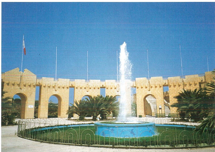
The jet d'eau at the National Park in Ta' Qali.
