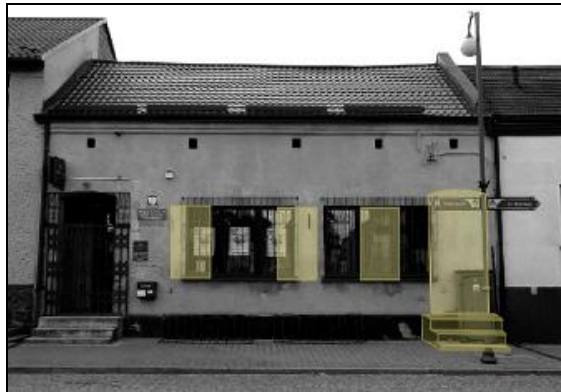
Fot. 3. Budynek przy rynku miejskim w Koziegłowach, w którym mieścił się do 1939 r. żydowski dom modlitw. Zdjęcie i rekonstrukcja przedwojennego układu wejść i otworów okiennych (fot. i opracowanie własne)
