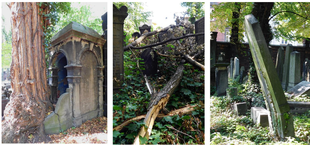
Ryc. 5. Wietrzenie biologiczne w obrębie cmentarzy (od lewej: Będzin – destrukcja ohelu powodowana przez rozrastające się drzewo, Mikołów – połamane gałęzie zagrażające macewom, Bytom – pędy bluszczu przyczyniły się do pochylenia macewy (fot. Anna Majewska).
