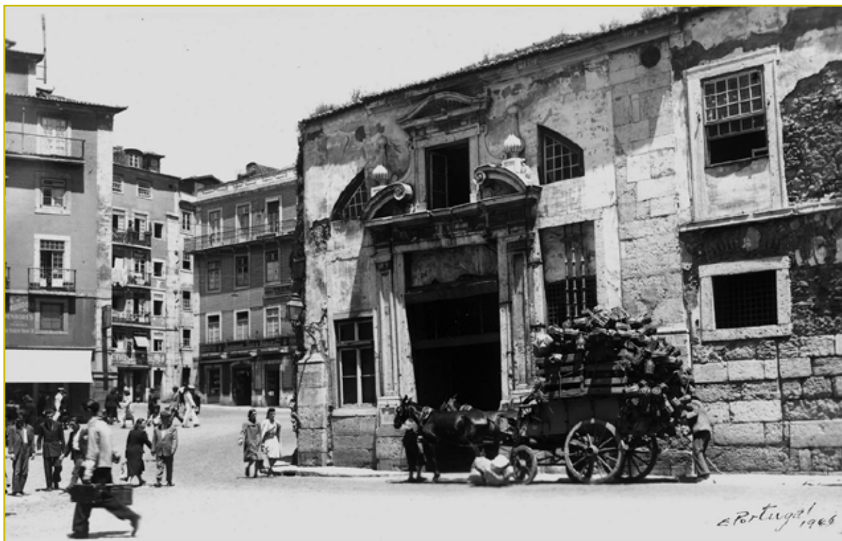
Figura 6 Portal poente da fachada sul, sobre o largo Silva e Albuquerque (Fotografia de Eduardo Portugal, 1946. AML, PT/AMLSB/POR/058457).
