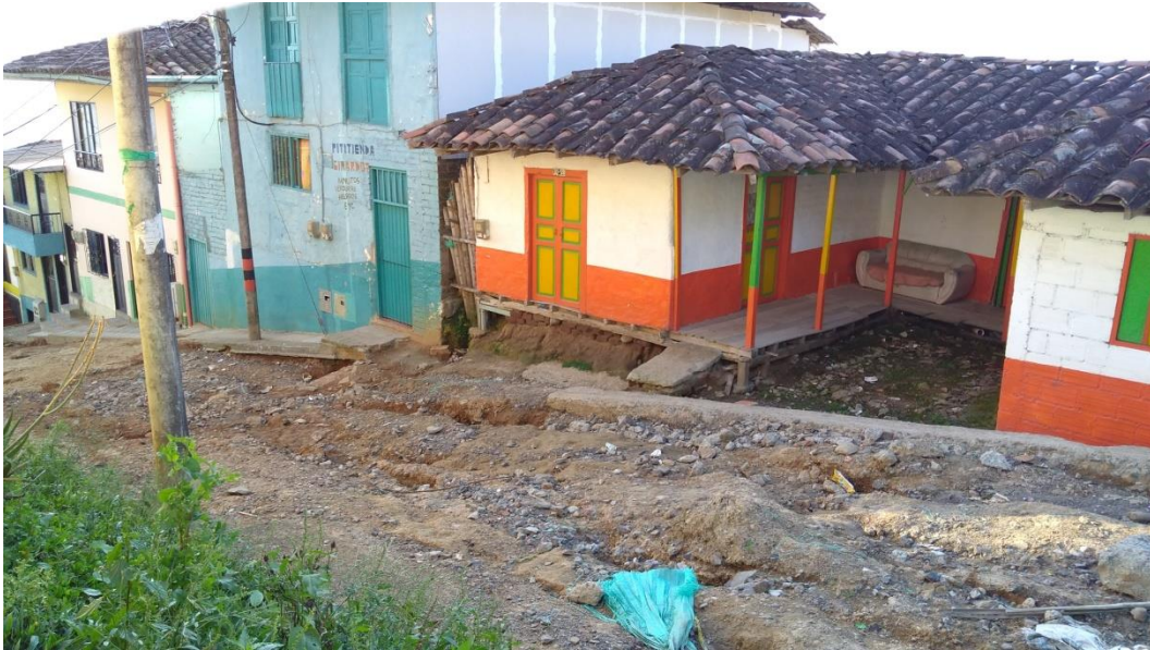
Fotografía N° 1. Reparación de vía sector barrio Santa Inés
