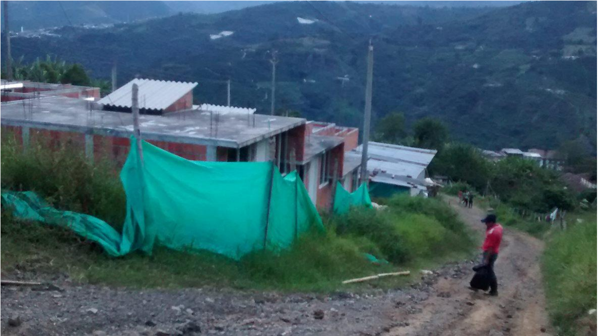
Fotografía N° 5. Vía de acceso barrio San Daniel
