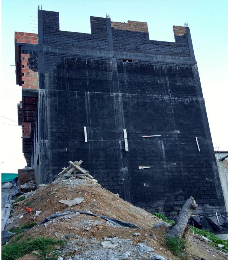
Fotografía N° 7. Construcción sector Telecom
