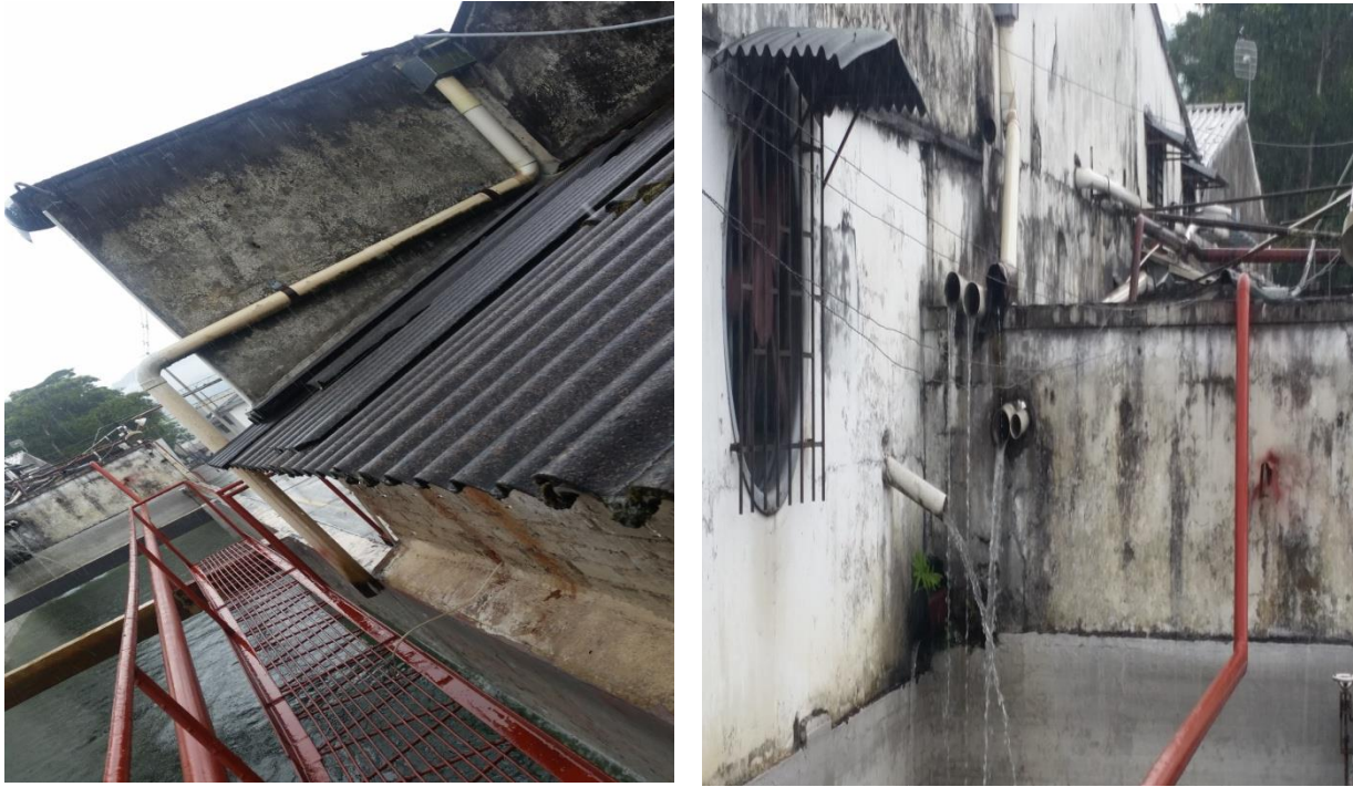
Anexo 8. Sistema interconectado de canales en los techos, (Fuente: Propia, 2017)
