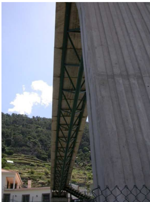
Figura 3-9 - Vista inferior da ponte pedonal
