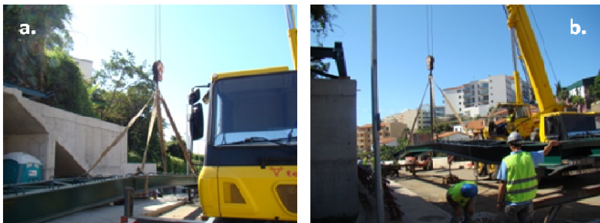
Figura 3-40 – Montagem da estrutura metálica principal
