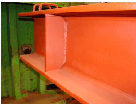
Figura 3-36 – Pormenores da estrutura do tabuleiro
