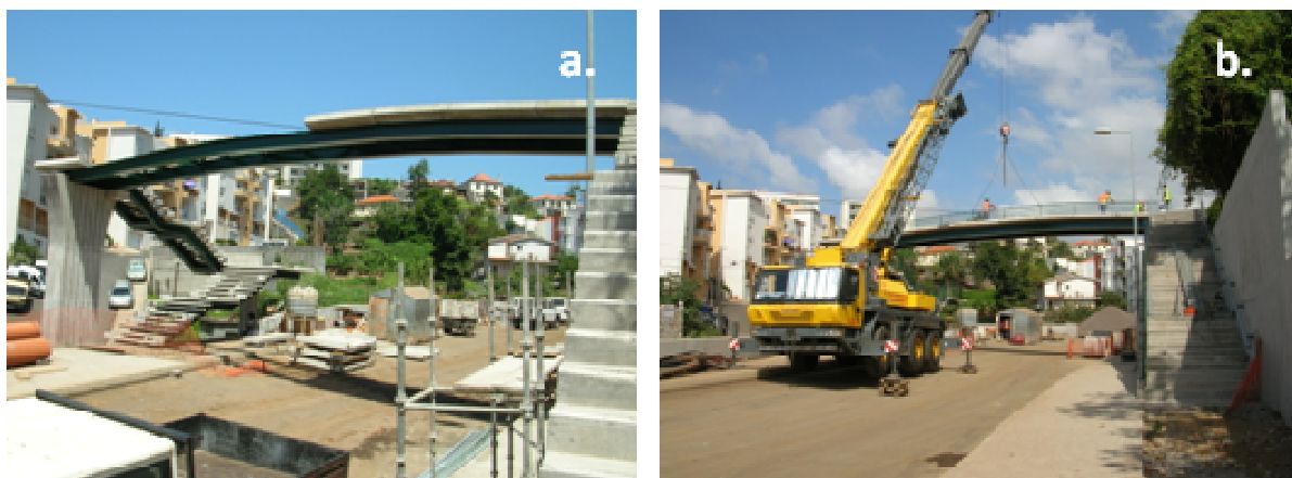
Figura 3-45 – Montagem das lajes pré-fabricadas
