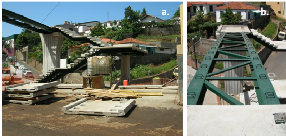
Figura 3-43 – a. Lajes de armado b. Início de montagem das lajes pré-fabricadas
