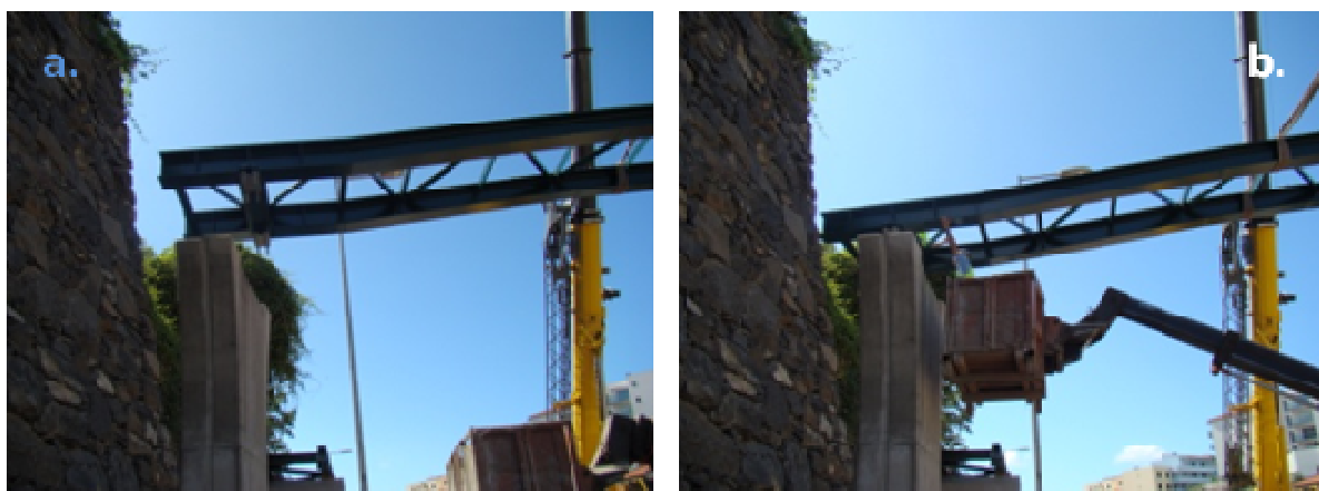
Figura 3-42 – Acerto da estrutura metálica principal sobre os pilares
