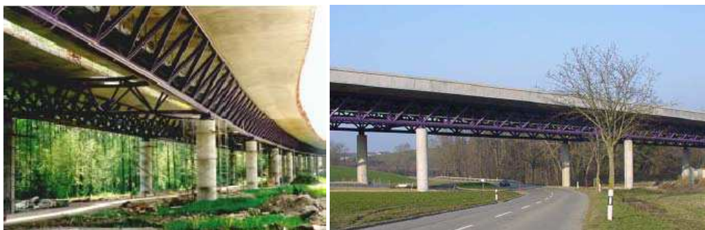
Figura 3-4 – Viaduto de Lully (Suíça) [9]
