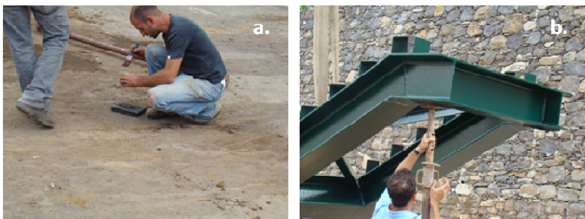
Figura 3-39 – Colagem dos apoios em neoprene
