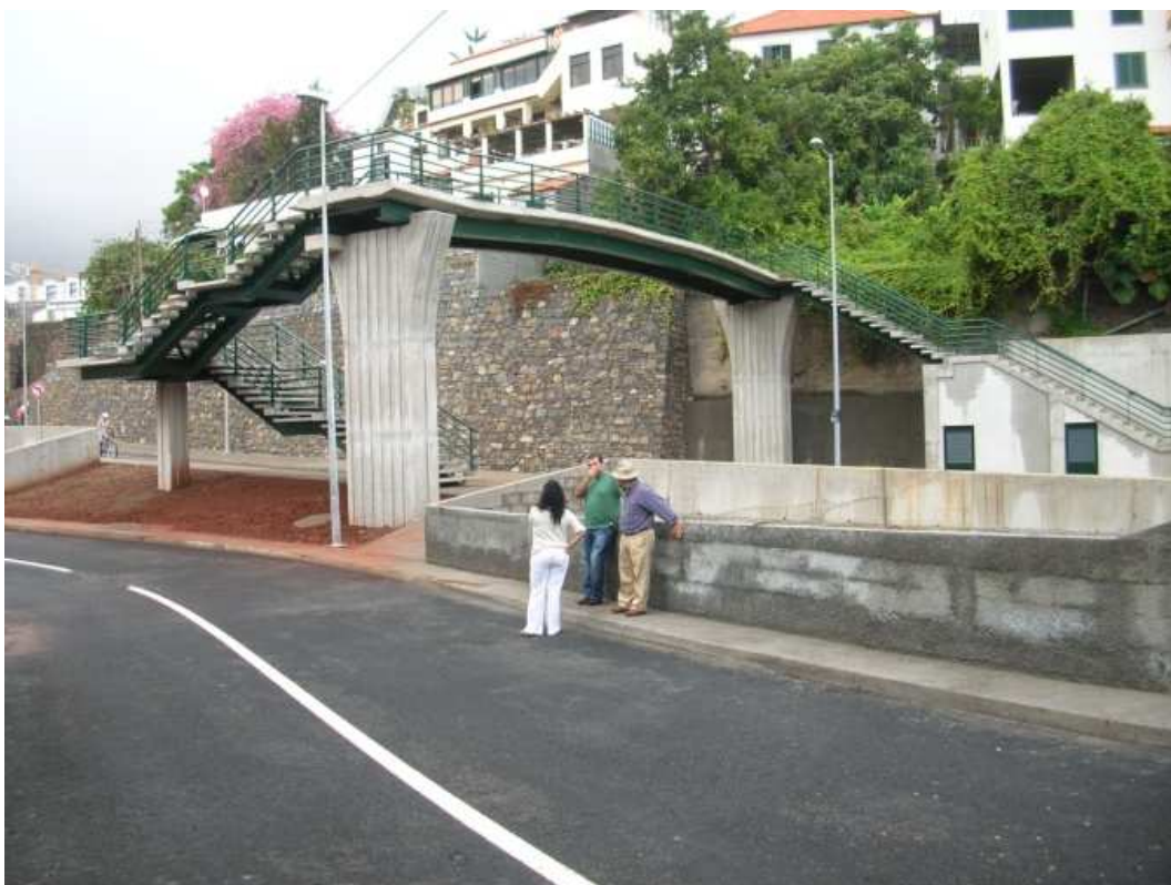
Figura 3-46 – Ponte após finalização dos trabalhos
