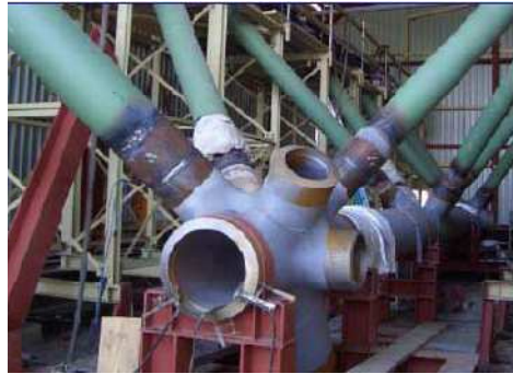
Figura 3-6 – Ligação pré-fabricada Ponte de St. Kilian, Alemanha [9]
