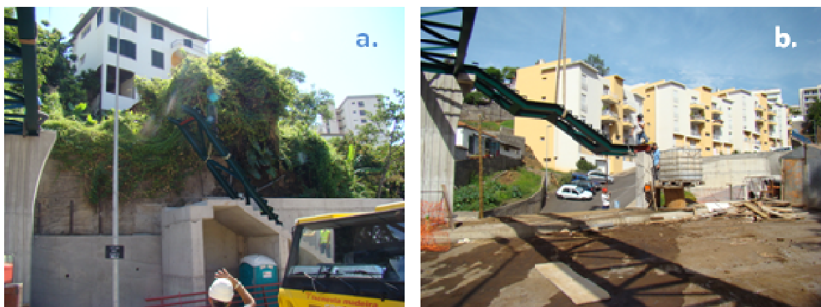
Figura 3-38 – Montagem de ambas as escadas
