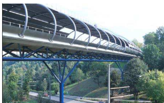
Figura 3-3 – Ponte Rodoviária de Nesenbachtal na Alemanha [9]
