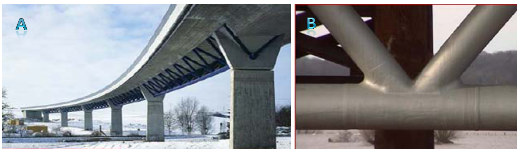
Figura 3-7 – Ponte de Korntal-Münchingen, Alemanha: A – vista geral; B – Nó de Ligação pré-fabricado em aço fundido [9]
