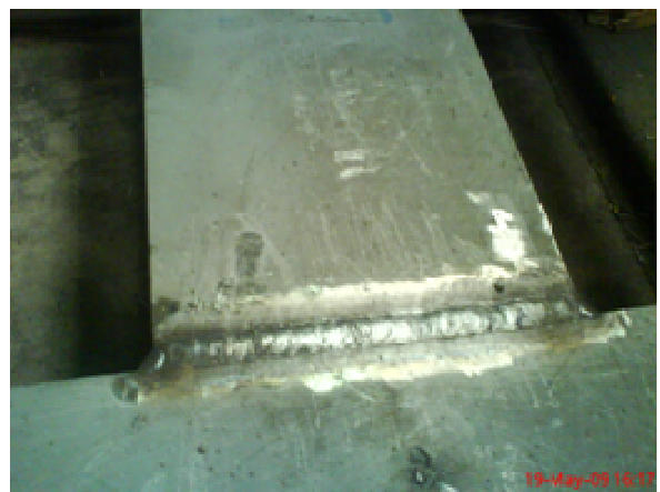
Figura 3-32 – Soldaduras nos perfis
