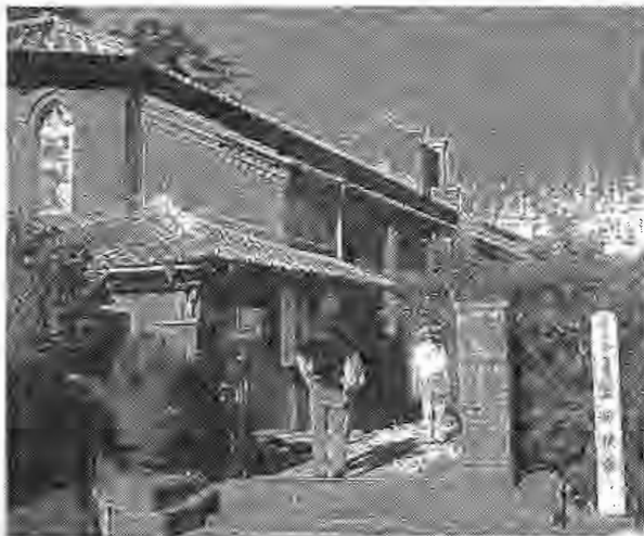
写真 14 堂崎天主堂（2004 年 8 月撮影）【左】
