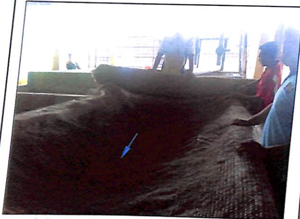
(d) Unroll the ECB for Laying Works
