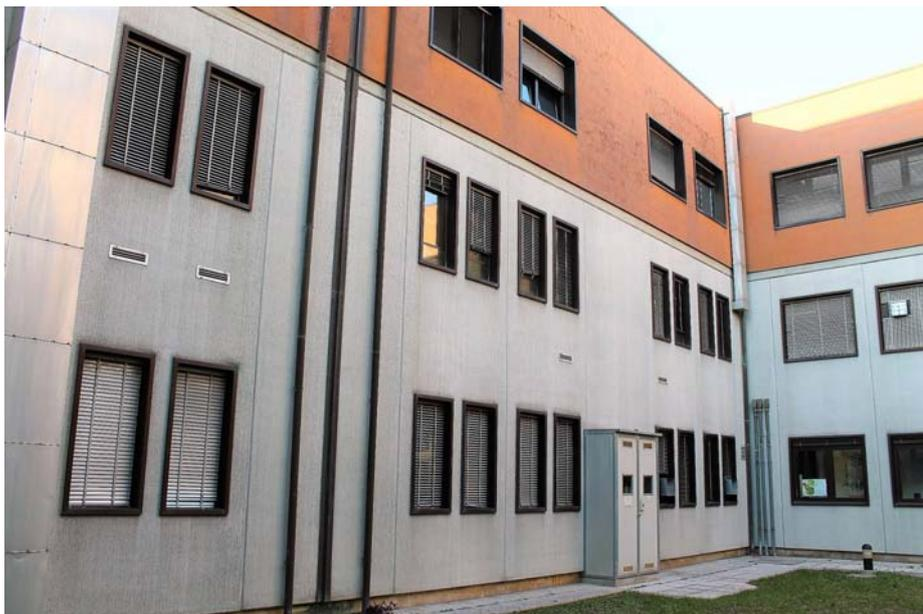
**Figura 1.11:** Vista della muratura di tamponamento del corpo R1. La sopraelevazione aggiunta in opera è facilmente identificabile dal diverso colore dell'intonaco esterno.
