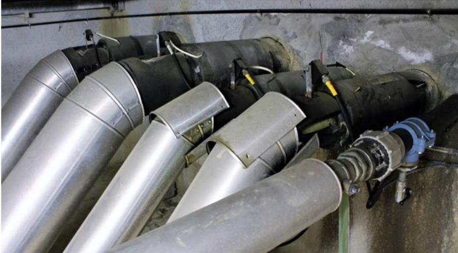
**Figura 1.5:** Stacco della rete di teleriscaldamento e raffrescamento di Area presso il livello inferiore dell'edificio 10.
