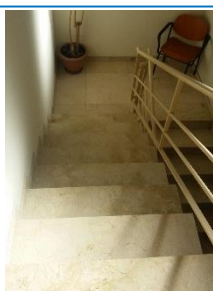
Escalera : MUTUAM Güell , Edificio No. 1
