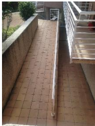
Rampa Edificio no.2 :MUTUAM Güell
