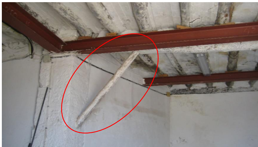
Ilustración 1: vigas de madera y el refuerzo estructural de hierro
