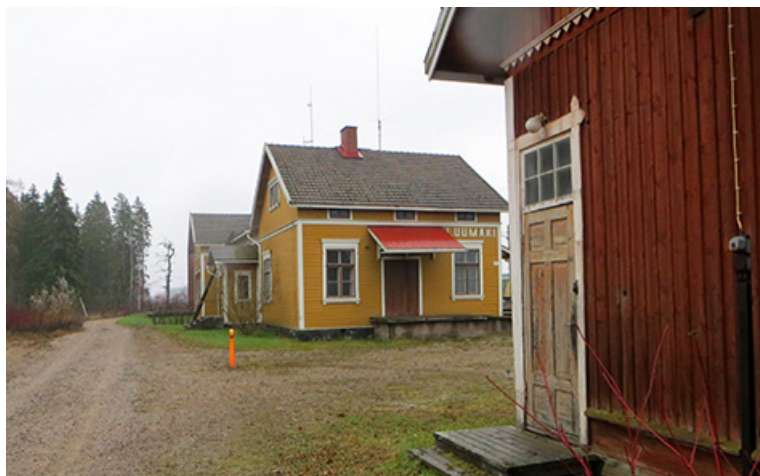
Luumäen aseman rakennuksia kesällä 2014. Kuva Yrjö Varpio.
