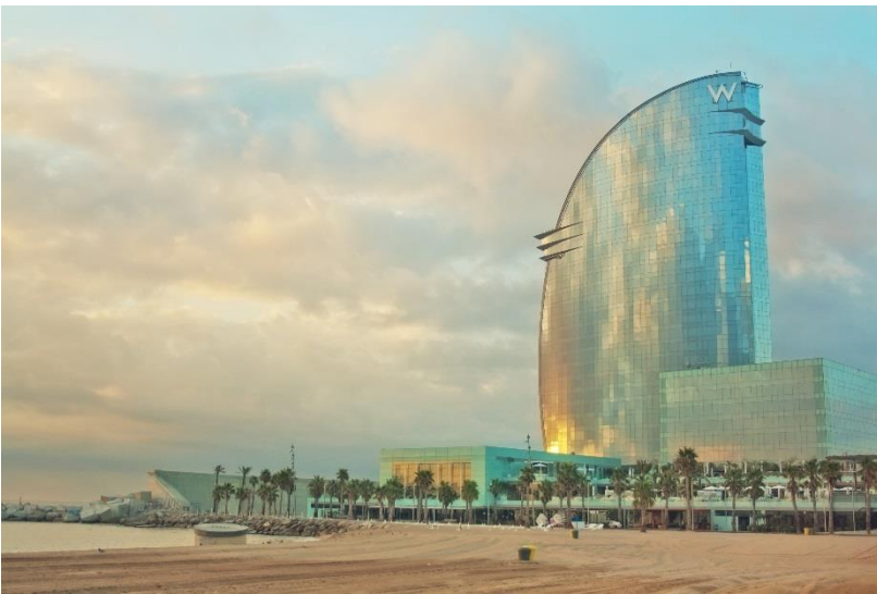
Kuva 213. W Barcelona Hotel. (Juanedc/ Wikimedia Commons).
