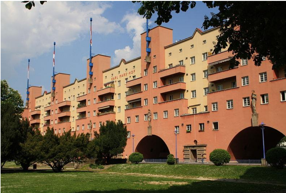
Kuva 151. Wienin 1920-luvun näyttävää työväenasuntorakentamista: Karl-Marx-Hof. (Dreizung/ Wikimedia Commons).
